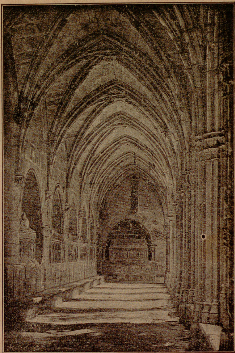
CLAÚSTRO PRINCIPAL NAVE NORTE LINDANTE A LA IGLESIA
