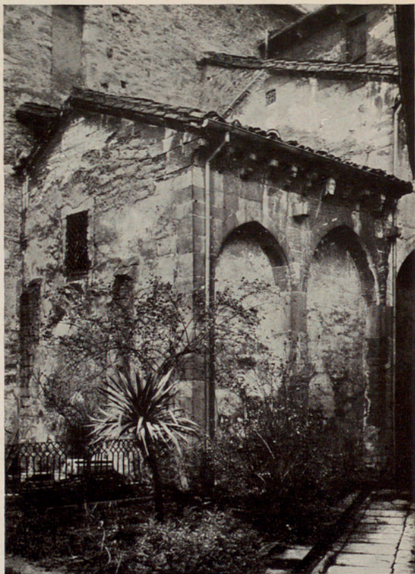
CÁMARA SANTA. VISTA EXTERIOR
