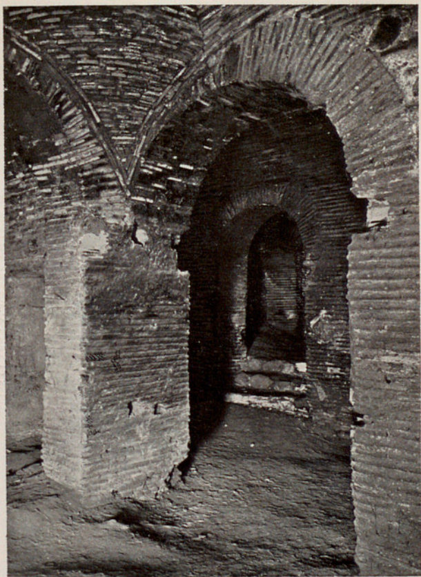
BÓVEDAS. ANTIGUA SINAGOGA
