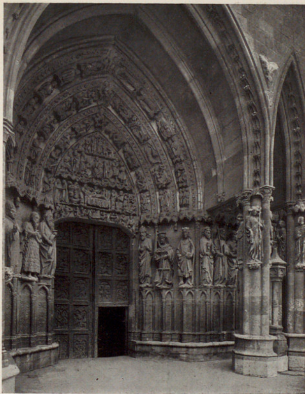
FACHADA PRINCIPAL. PUERTA LATERAL, LADO NORTE
