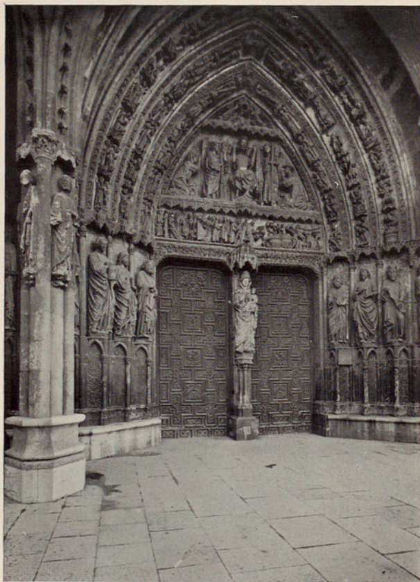
FACHADA PRINCIPAL. PUERTA DE NTRA. SRA. LA BLANCA
