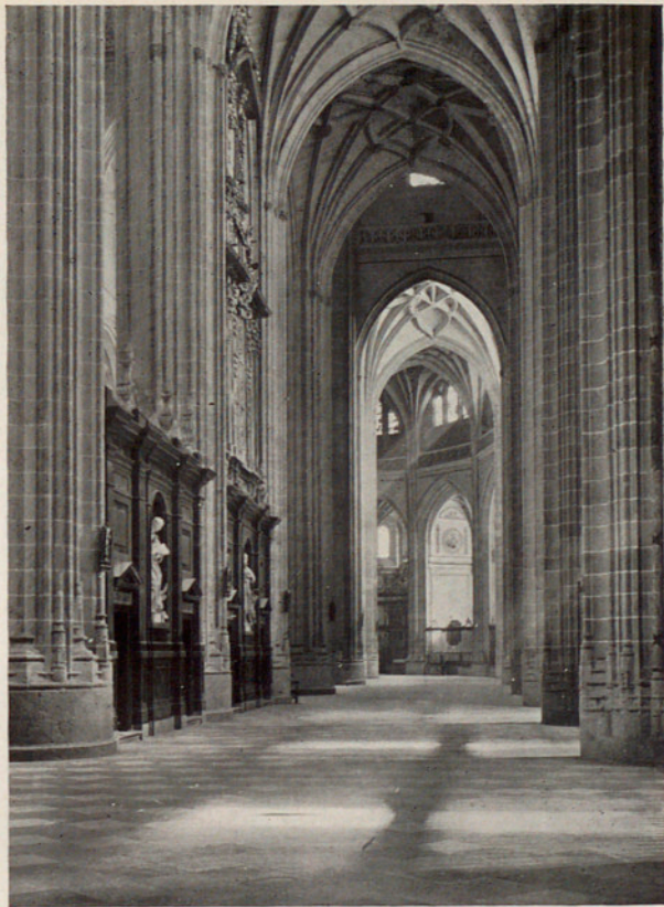
NAVE DE LA EPÍSTOLA
