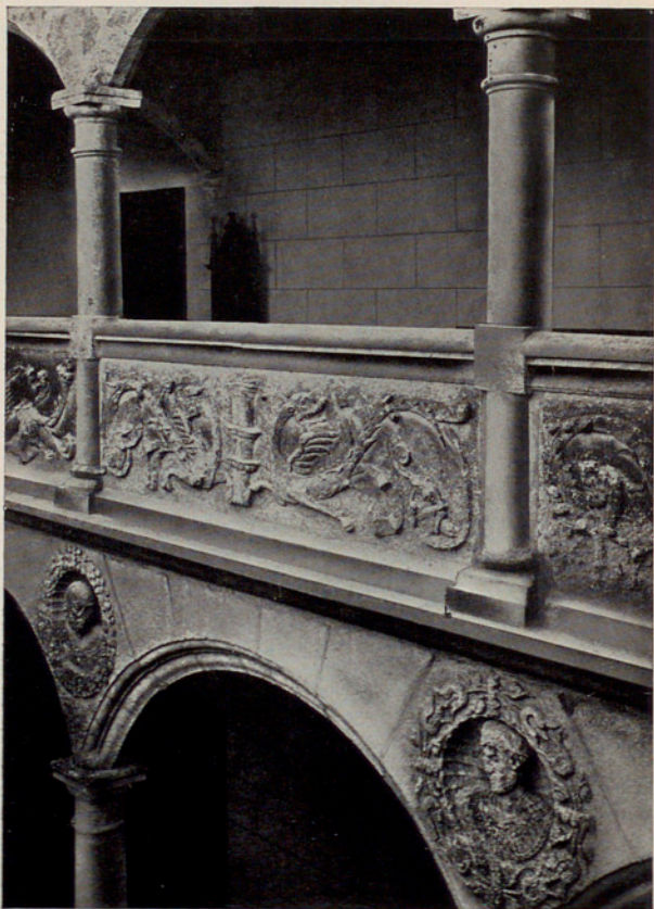
PALACIO DEL MARQUÉS DE LOS ALTARES. DETALLE DE LA GALERÍA DEL PATIO
