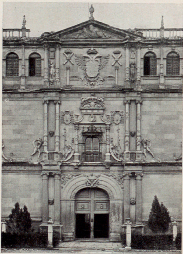
ALCALÁ. - UNIVERSIDAD. DETALLE DE LA FACHADA PRINCIPAL
