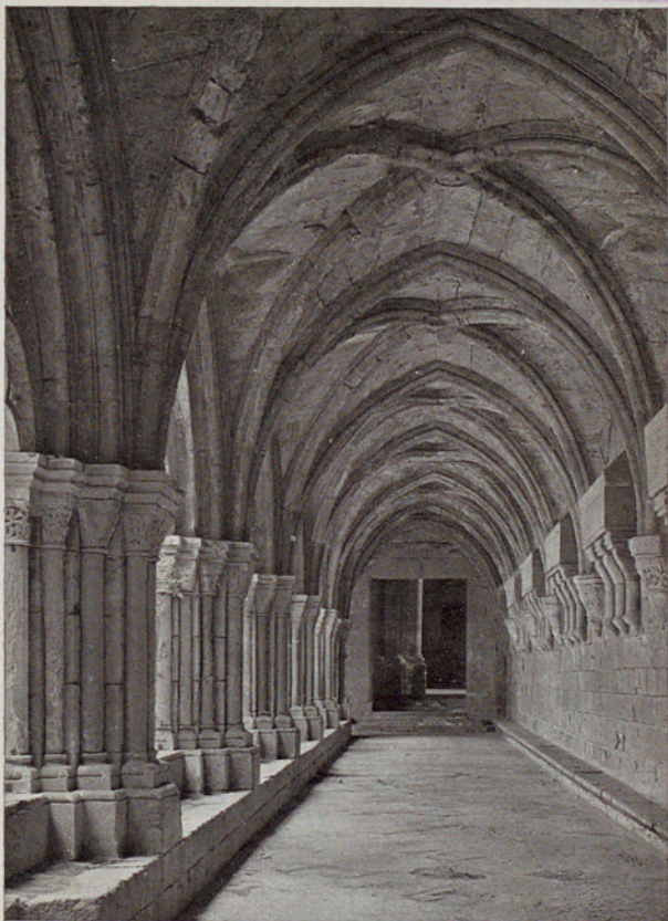
GALERÍA PONIENTE DEL CLAUSTRO
