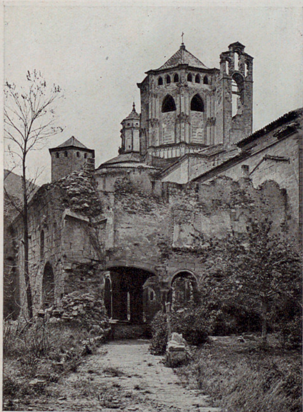
CIMBORIO, CAMPANARIO, CLAUSTRI- CIMBORIUM, CLOCHER, PETIT LLOS Y RUINAS DE LA ENFERMERÍA CLOÎTRE ET RUINES DE L'INFIRMERIE THE LANTERN BELL-TOWER, MINOR CLOISTERS, AND RUINS OF THE INFIRMARY
