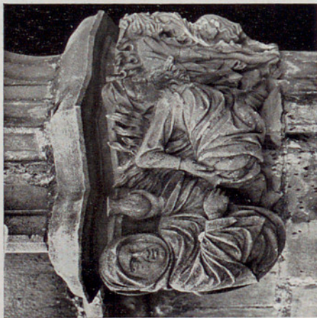
IMPOSTAS DE VENTANA EN EL PALACIO REAL.
