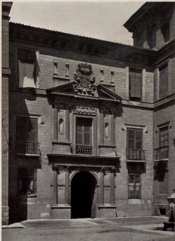
FACHADA DE LA CASA DE FABIO NELI, OBRA DE PEDRO DE MA- ZUECOS. 1594
