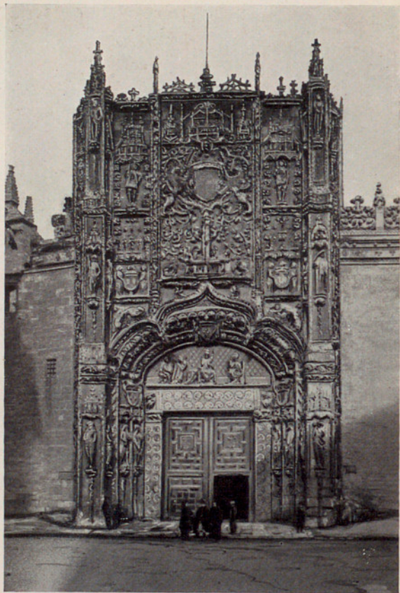
FACHADA DEL COLEGIO DE SAN GREGORIO. HACIA 1492
