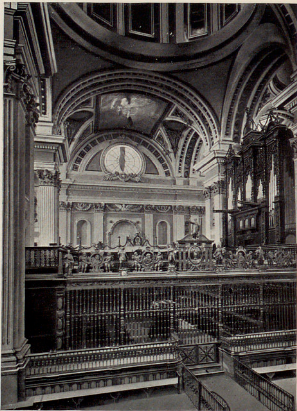
CATEDRAL DEL PILAR. REJA DEL CORO MAYOR. EXTERIOR
