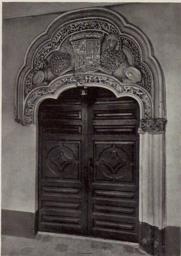
PALACIO DE LA ALJAFERÍA. PUERTA PALAIS DE LA ALJAFERÍA. PORTE DE ENTRADA AL SALÓN DEL TRONO. D'ENTRÉE AU SALON DU TRÔNE ALJAFERIA PALACE. ENTRANCE TO THE TRONE ROOM
