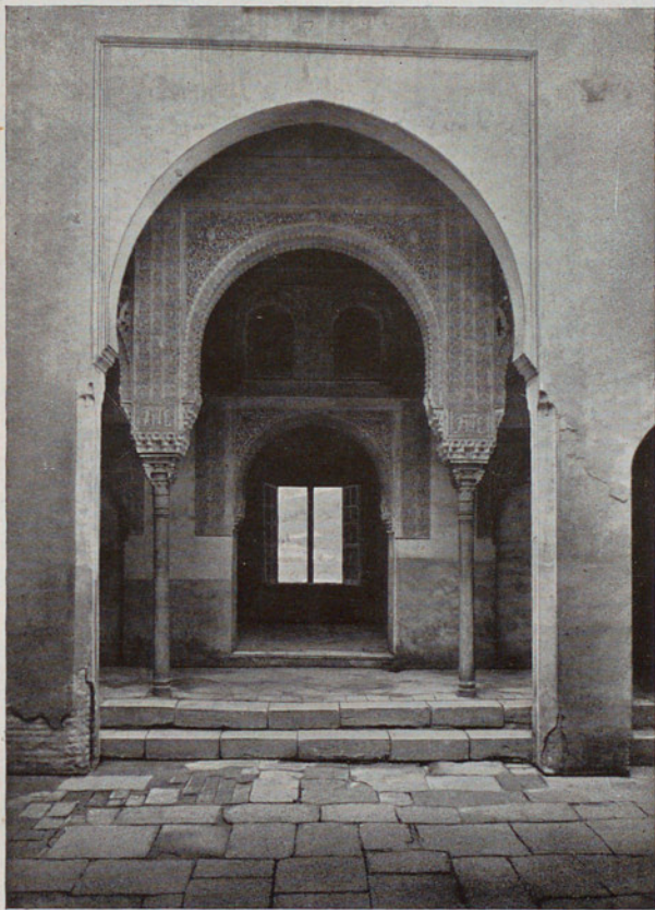
PATIO DE LA CAPILLA
