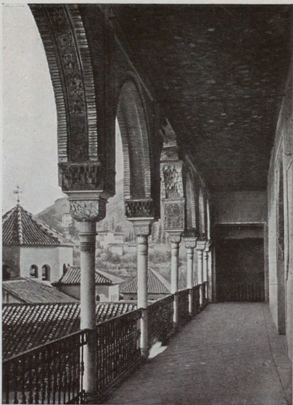
GALERÍA ALTA DEL PATIO DE LA ALBERCA
