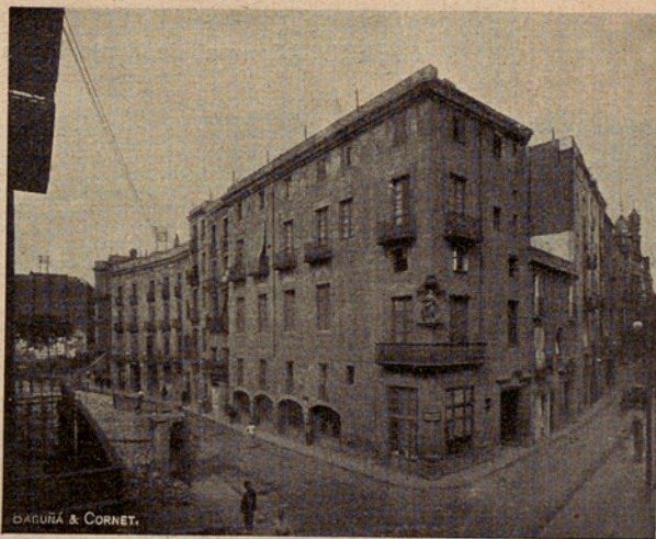
Conjunt de la casa gremial en la cantonada dels carrers Alt de Sant Pere y Archs de Jonqueres
