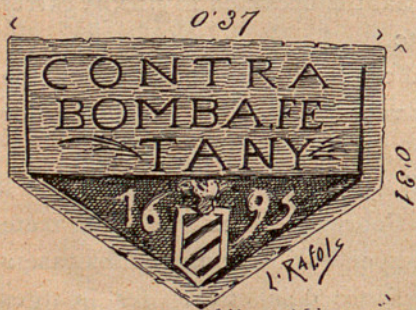
Pedra posada a la entrada de la habitació a proba de bomba en una casa del carrer de Na Avellana
