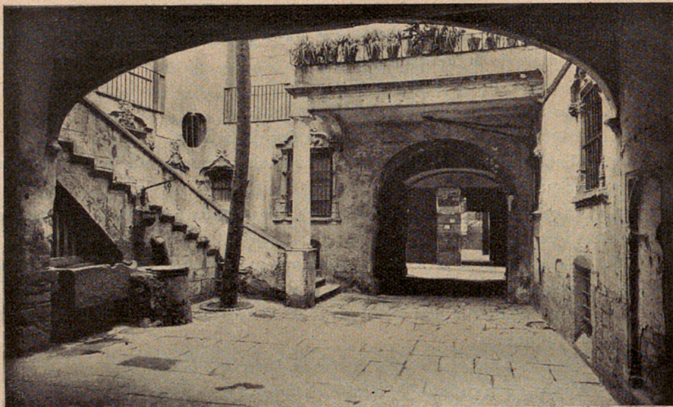
891.—Pati de la casa Padellàs, obrat en lo segle xvi, que no desapareix ab la Vía Layetana
