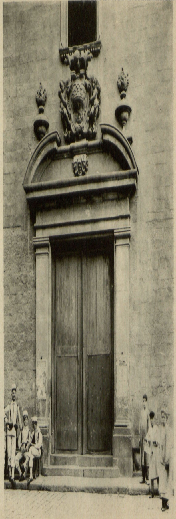
EL BUENSUCESO DE SERVITAS DE BARCELONA 1909
