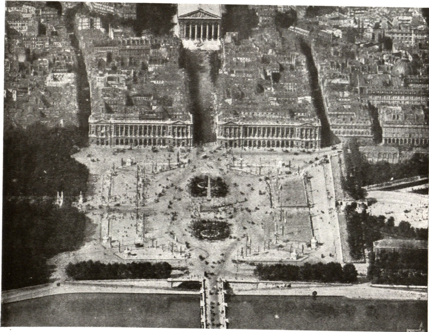
Plaça de la Concòrdia Vista des d'un avió; a l'esquerra es veu el mur de contenció de l'àrea desmuntada.
