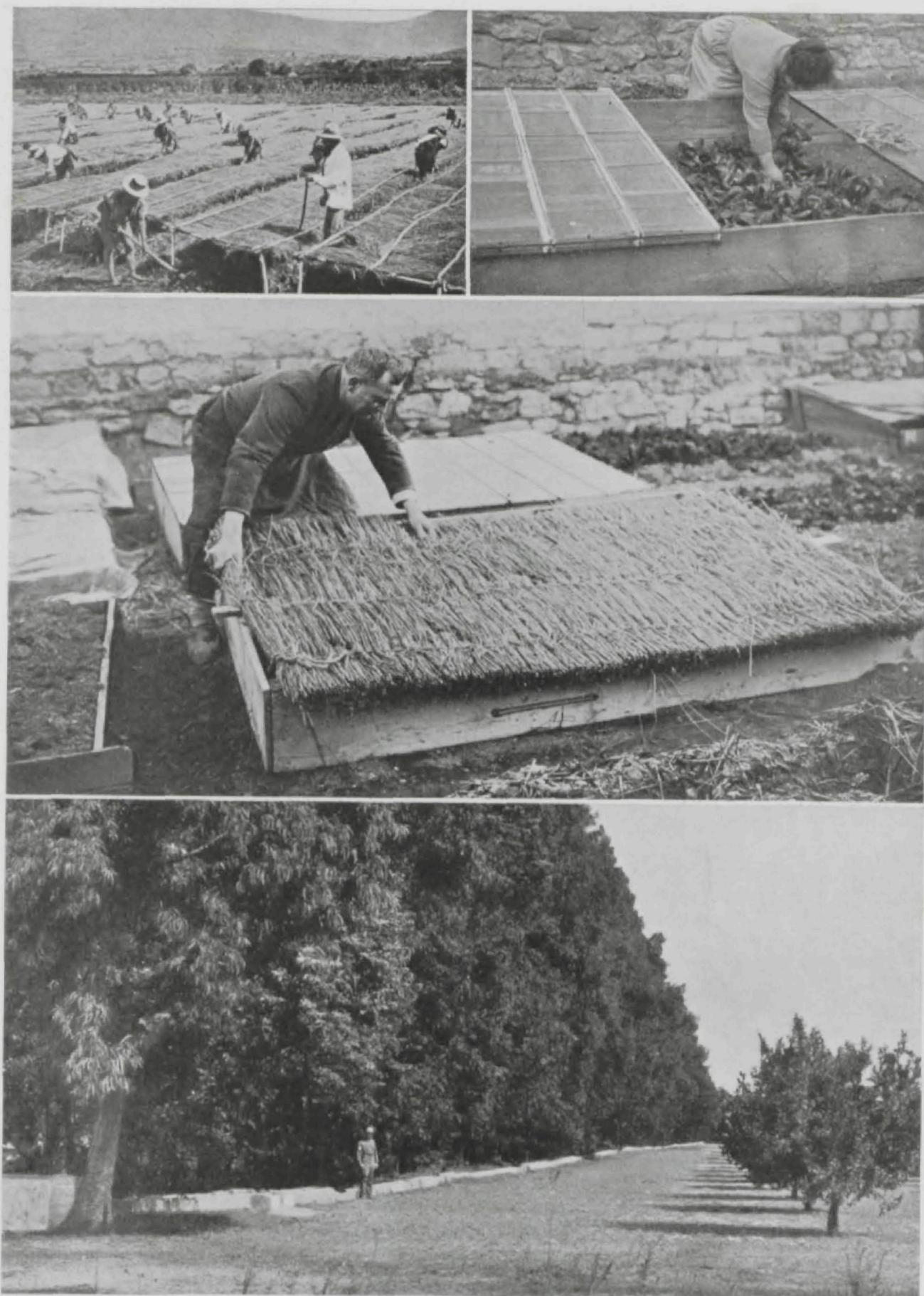
Abrigo con ramas de brezo, en un criadero. — Id. con vidrieras. — Abrigo temporal de estera de paja de centeno para semilleros. — Cortina de eucaliptos que resguarda un limonar, formando un abrigo natural.
