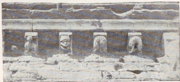
MÈNSULES DE LA FAÇANA SUD DE LA NAU
