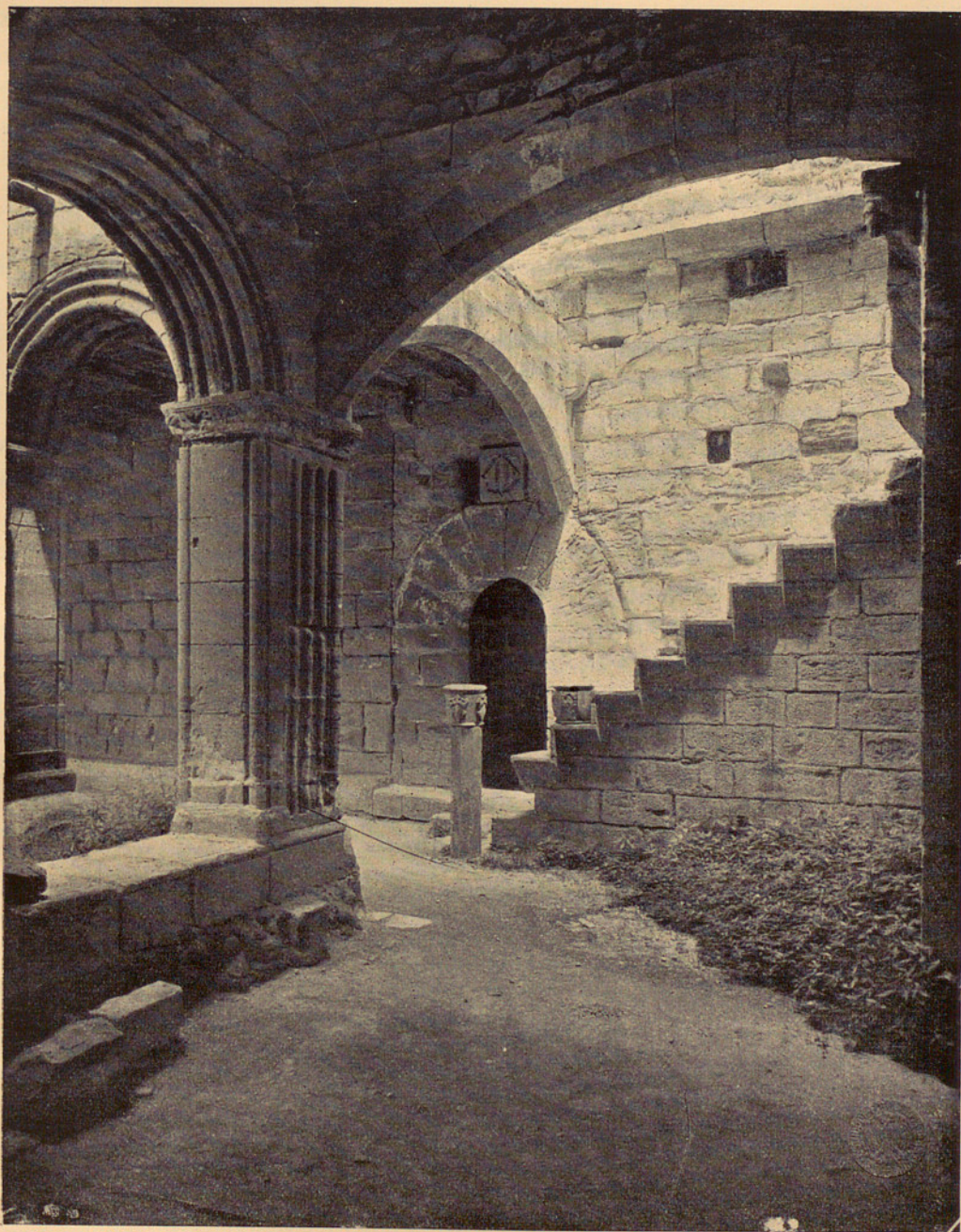
CLAUSTRILLO DE SAN ESTEBAN Y ESCALERA DE LAS HABITACIONES REALES
