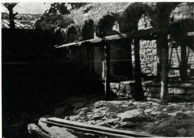
El claustre de Mur durant les obres de restauració.
