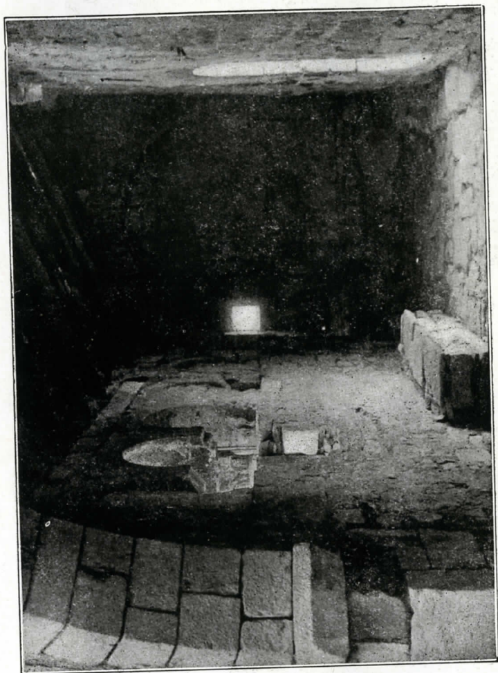
Una ala del claustre de Mur abans d'ésser restaurat
