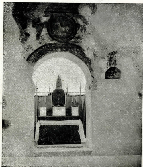
Arc triomfal en forma de ferradura, existent a l'església de Santa Coloma, el qual restava ocult per l'altar i un massís de mamposteria, afegits probablement el segle XVIII.
