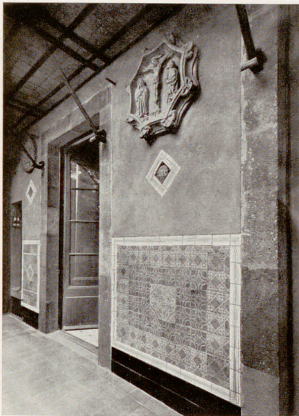
FACHADA NORTE. DETALLE
