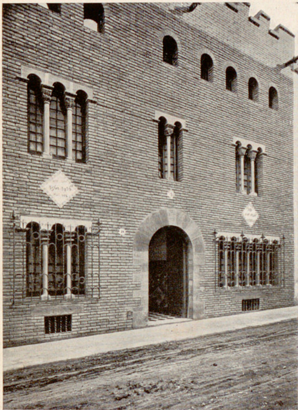
FACHADA A LA CALLE
