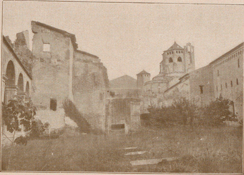
Patio de las Casas nuevas
