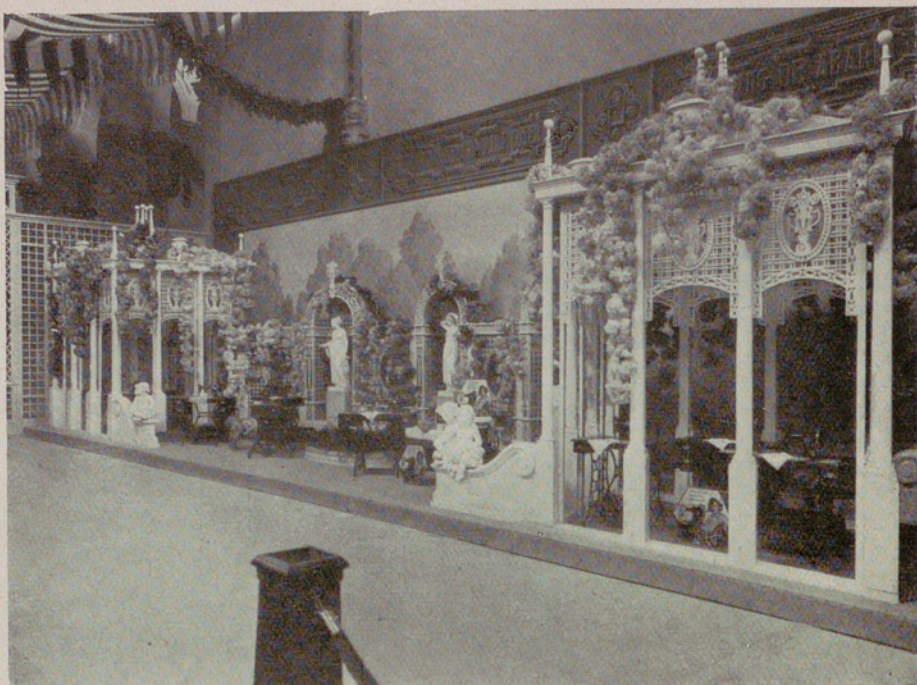
Instal·lacions de la Secció Tercera.
