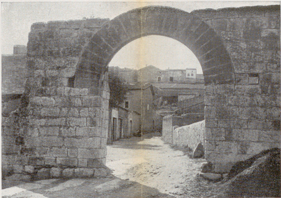
Espluga - Portal de la Font Major
