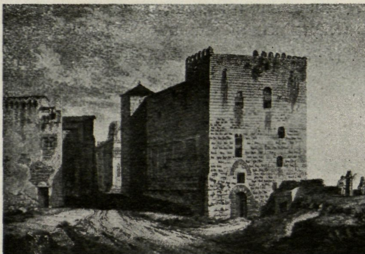
Fig. 50. — Tarragona : Castell de Pilat (Laborde)
