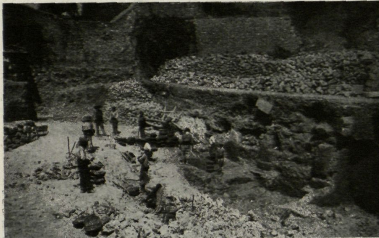
Fig. 251. — Tarragona : Pilars del pulpitum durant les excavacions
