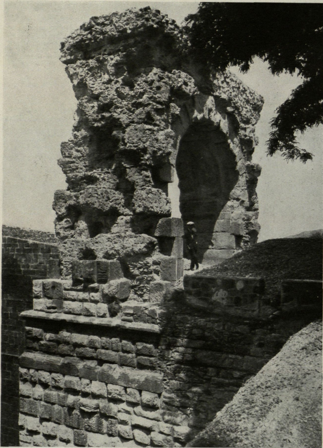
Fig. 233. — Martorell : Arc del «Pont del Diable» ( Servei de Conservació i Catalogació de Monuments )
