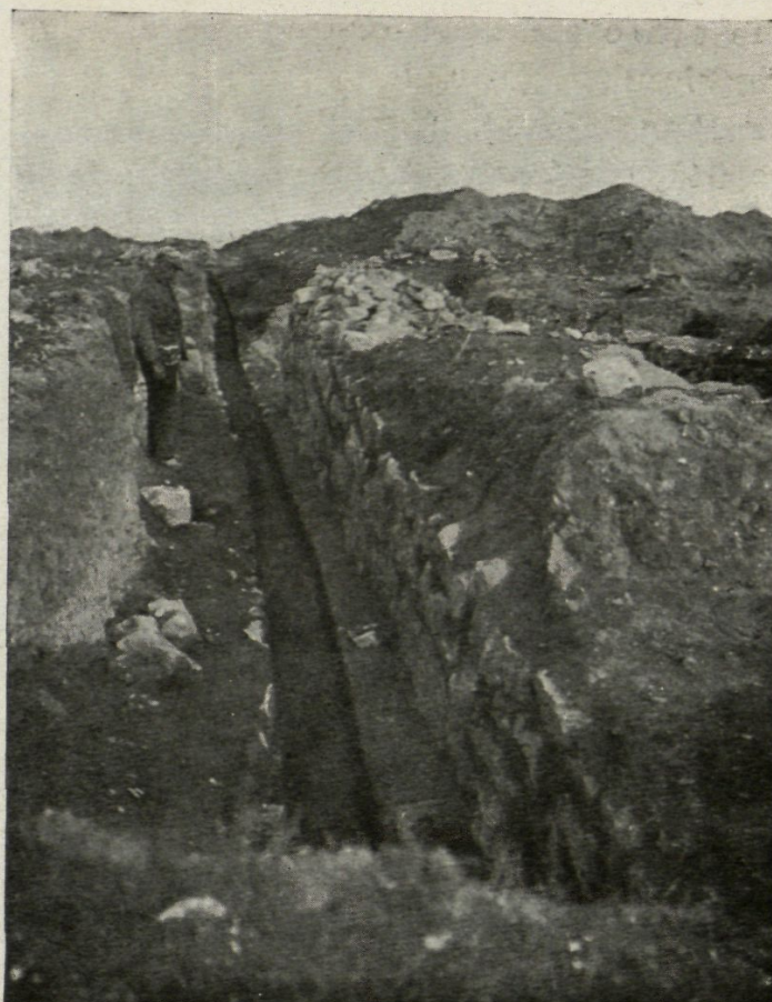
Fig. 71. — Empúries : Muralla en direcció d'E. a O. que divideix l'actual recinte romà (Gandia)
