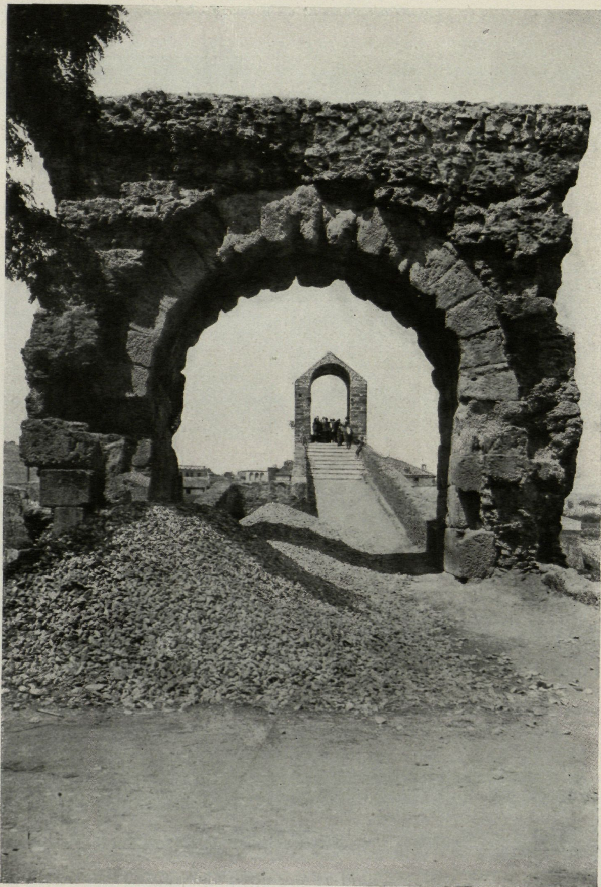
Fig. 234. — Martorell : Arc del «Pont del Diable» ( Servei de Conservació i Catalogació de Monuments )
