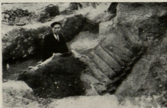
Cisterna coberta amb àmfores. Costat N. del macellum de Tarragona
