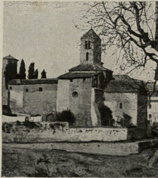
Fig. 18. — Santuari de Santa Maria de Terrassa abans de la restauració
