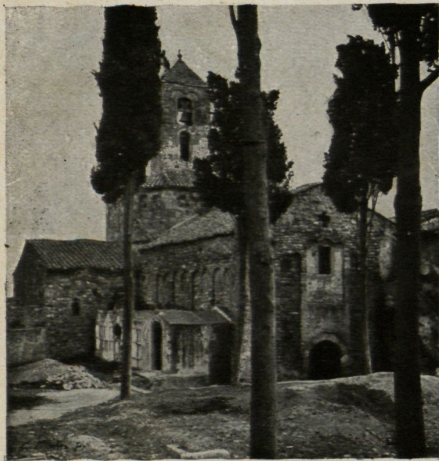
Fig. 19. — Transcepte i nau del segle XI del santuari de Santa Maria abans de la restauració
