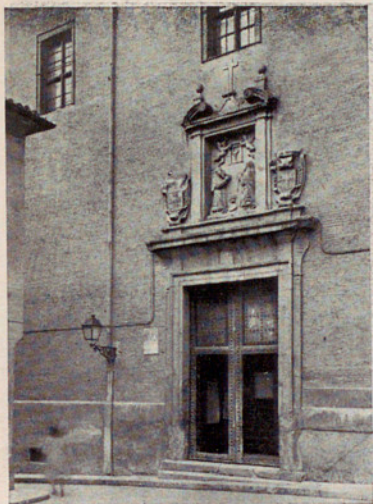
LAS CARBONERAS. FACHADA.
