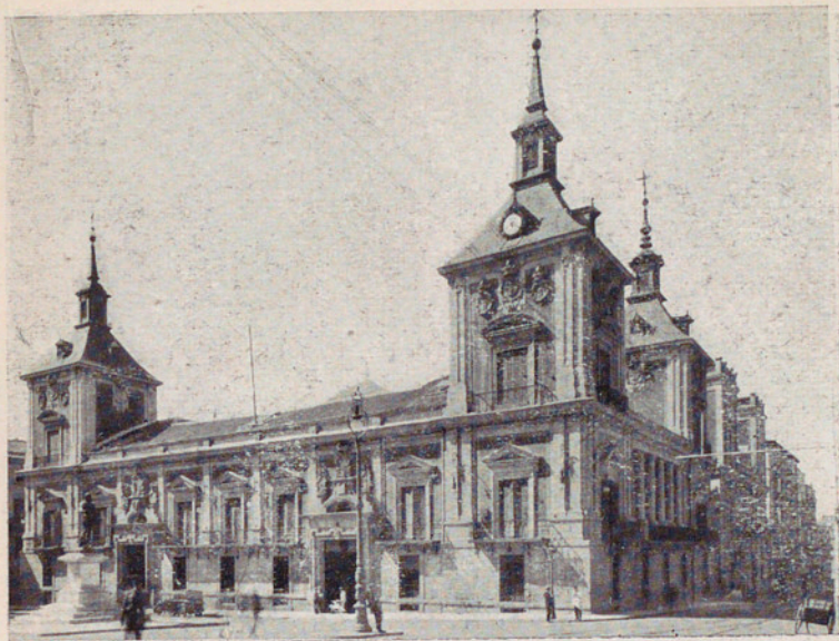
CASA CONSISTORIAL. FACHADA.
