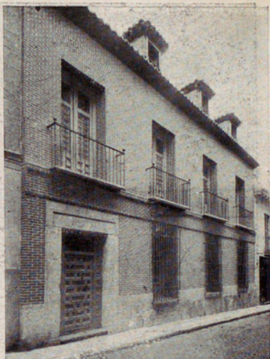
CASA DE LOPE DE VEGA. EXTERIOR
