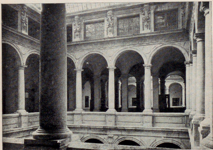
MINISTERIO DE ASUNTOS EXTERIORES. FACHADA Y PATIO
