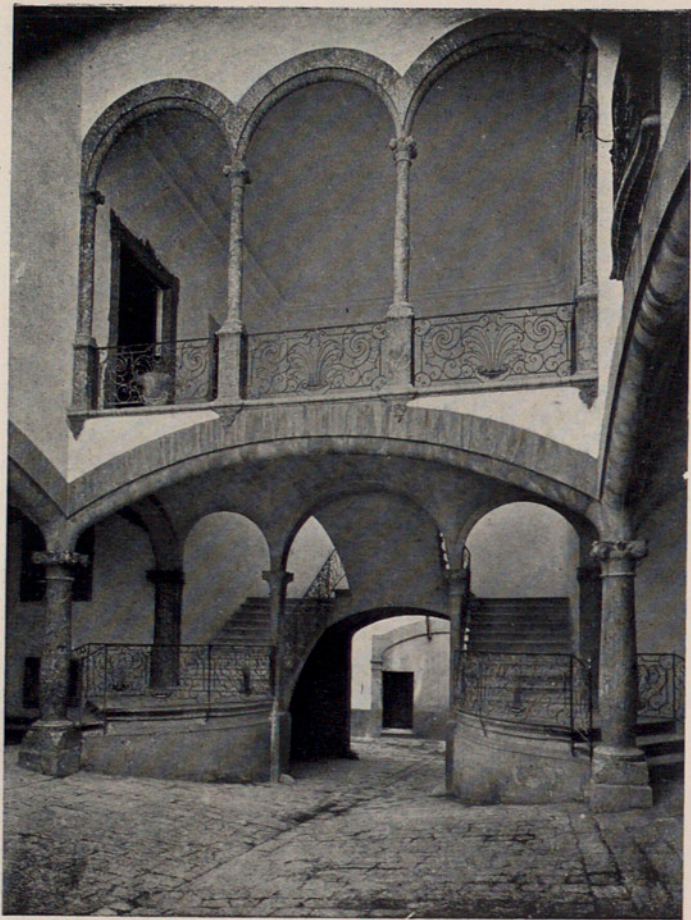
PATI DEL PALAU DEL MARQUÈS DE SOLLERICH. PATIO DEL PALACIO DEL MARQUÉS DE SOLLERICH. COUR DU PALAIS DU MARQUIS DE SOLLERICH. COURT OF THE PALACE OF THE MARQUIS DE SOLLERICH.
