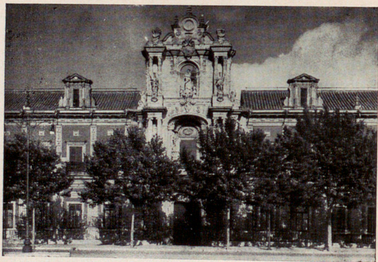
FACHADA DEL PALACIO DE SAN TELMO
