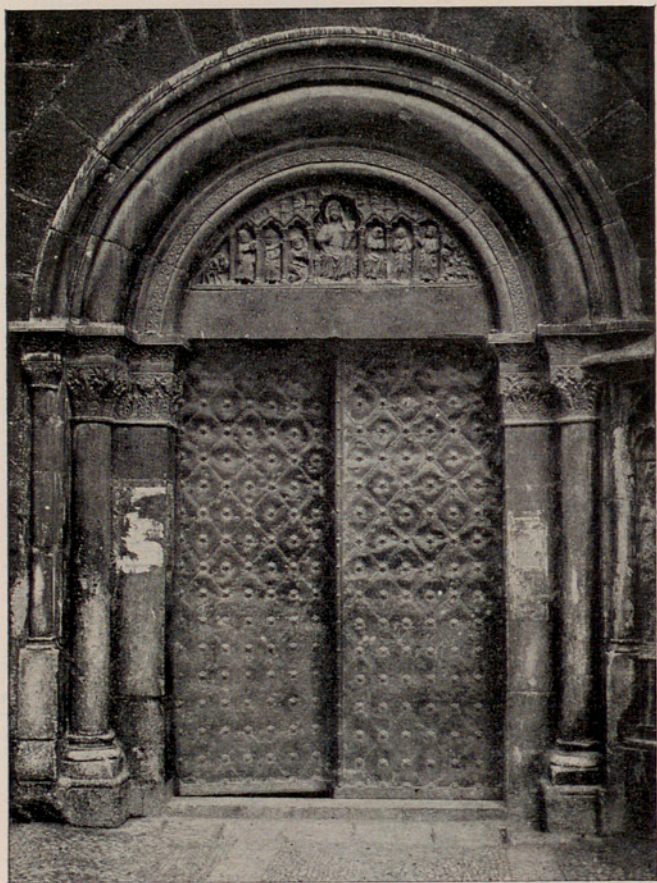
CATEDRAL. PUERTA LATERAL. CATHÉDRALE. PORTE LATÉRALE. CATHEDRAL. SIDE DOOR.
