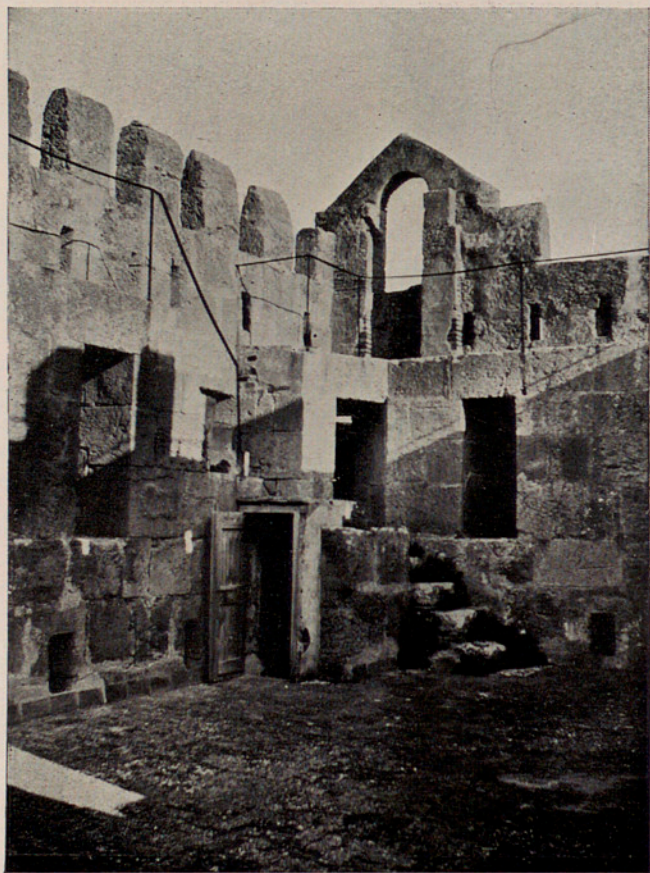
TERRADO DE LA TORRE DEL ARZOBISPO. INTÉRIEUR DU SOMMET DE LA TOUR DE L'ARCHEVÊQUE. TERRACE OF THE ARCHBISHOP'S TOWER.
