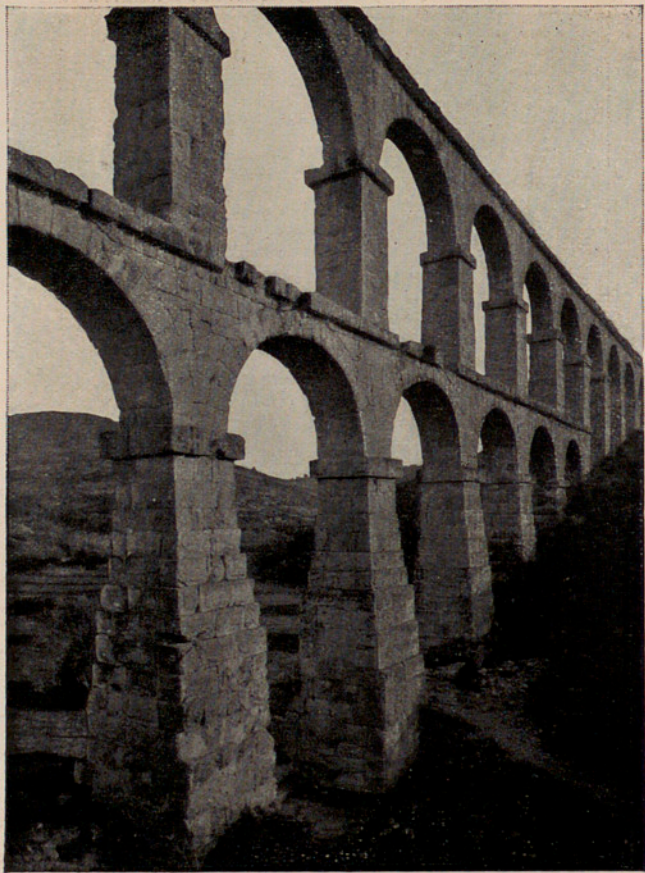
ACUEDUCTO DE "LAS FARRERAS".
