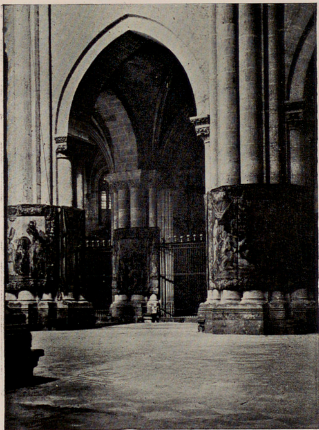
CATEDRAL. INTERIOR, DETALLE. CATHÉDRALE. DÉTAIL DE L'INTÉRIEUR. CATHEDRAL. DETAIL OF INTERIOR.
