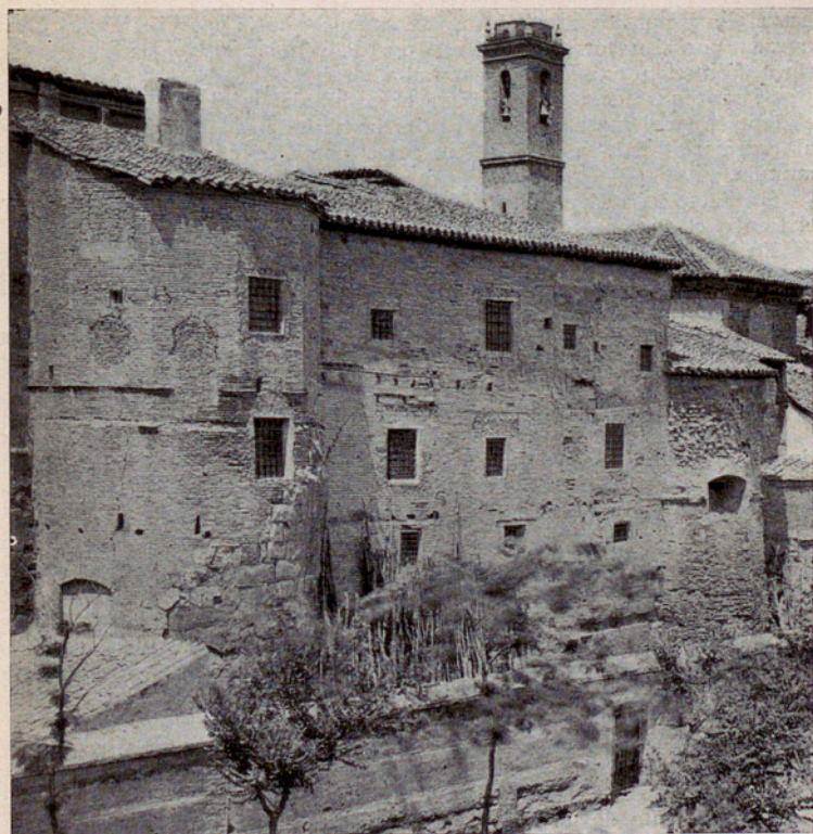
RESTOS DE LAS ANTIGUAS MURALLAS
