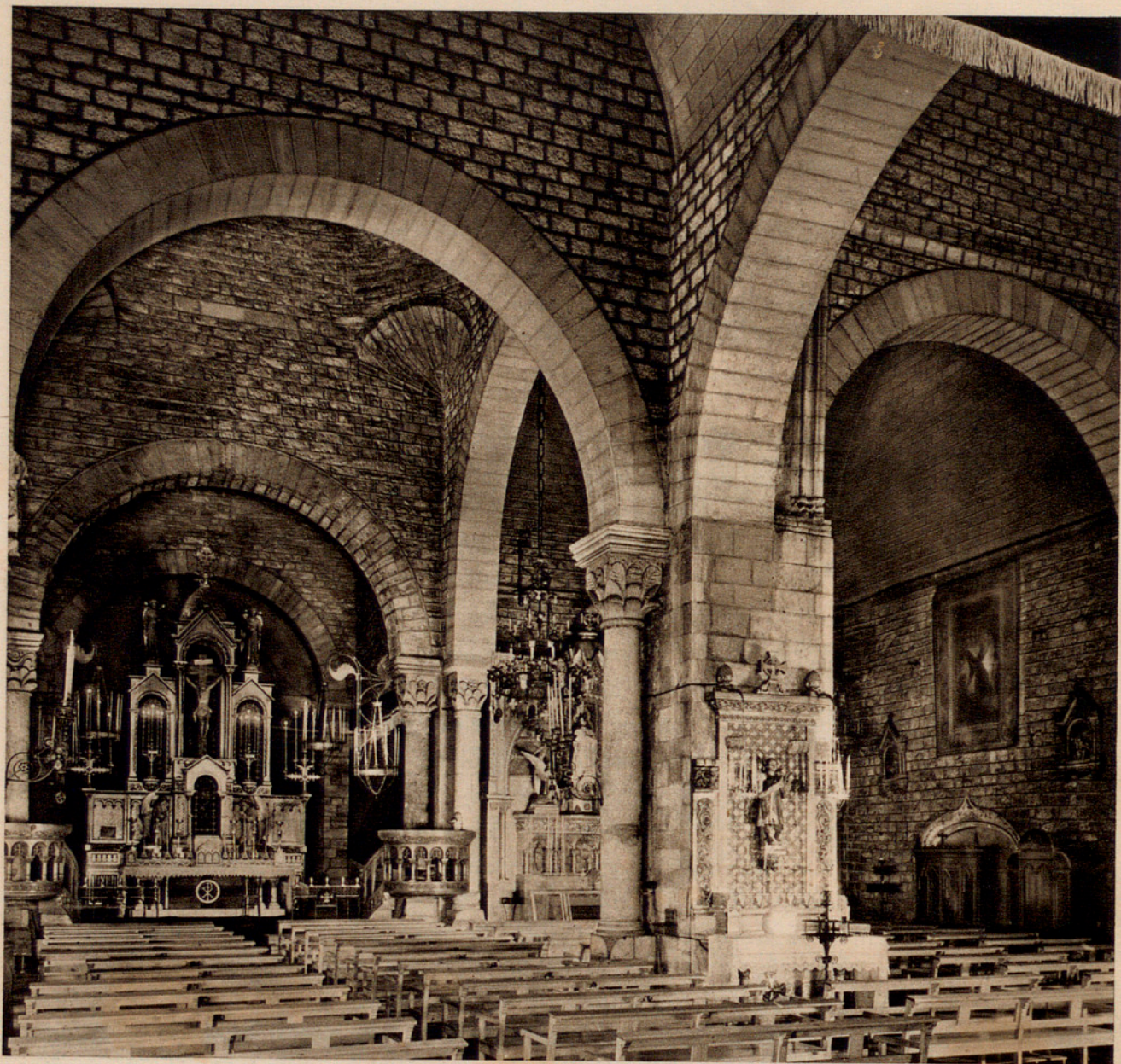
Fig. 1. — INTERIOR RESTAURADO DE LA IGLESIA DE SAN PEDRO DE LAS PUELLAS, BARCELONA.
