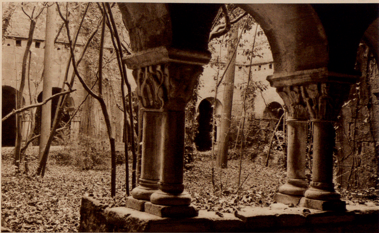
Fig. 117. — CLAUSTRO DEL MONASTERIO DE SAN BENITO DE BAGES (BARCELONA).
