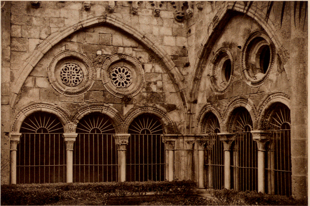
Fig. 171.—DETALLE DEL CLAUSTRO DE LA CATEDRAL DE TARRAGONA.
