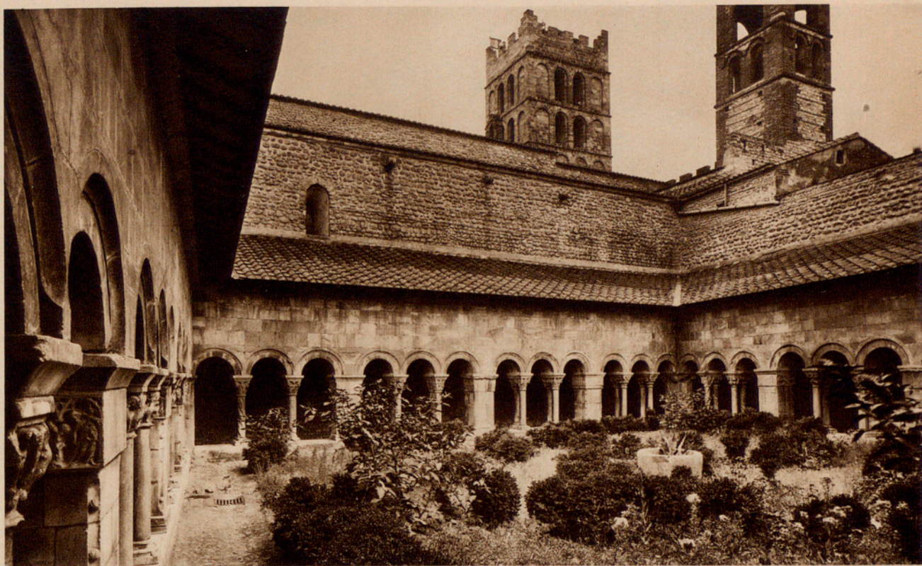
Fig. 94. — CLAUSTRO DE LA CATEDRAL DE ELNA (ROSELLÓN).
