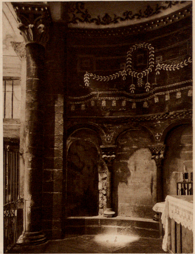
Fig. 235.—INTERIOR DE LA ERMITA DEL CRISTO DE CATALAIN (NAVARRA).
