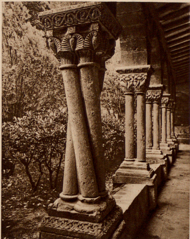
Fig. 281.—CLAUSTRO DE LA IGLESIA DE SAN PEDRO DE LA RUA, ESTELLA (NAVARRA). (Foto Lladó.)
