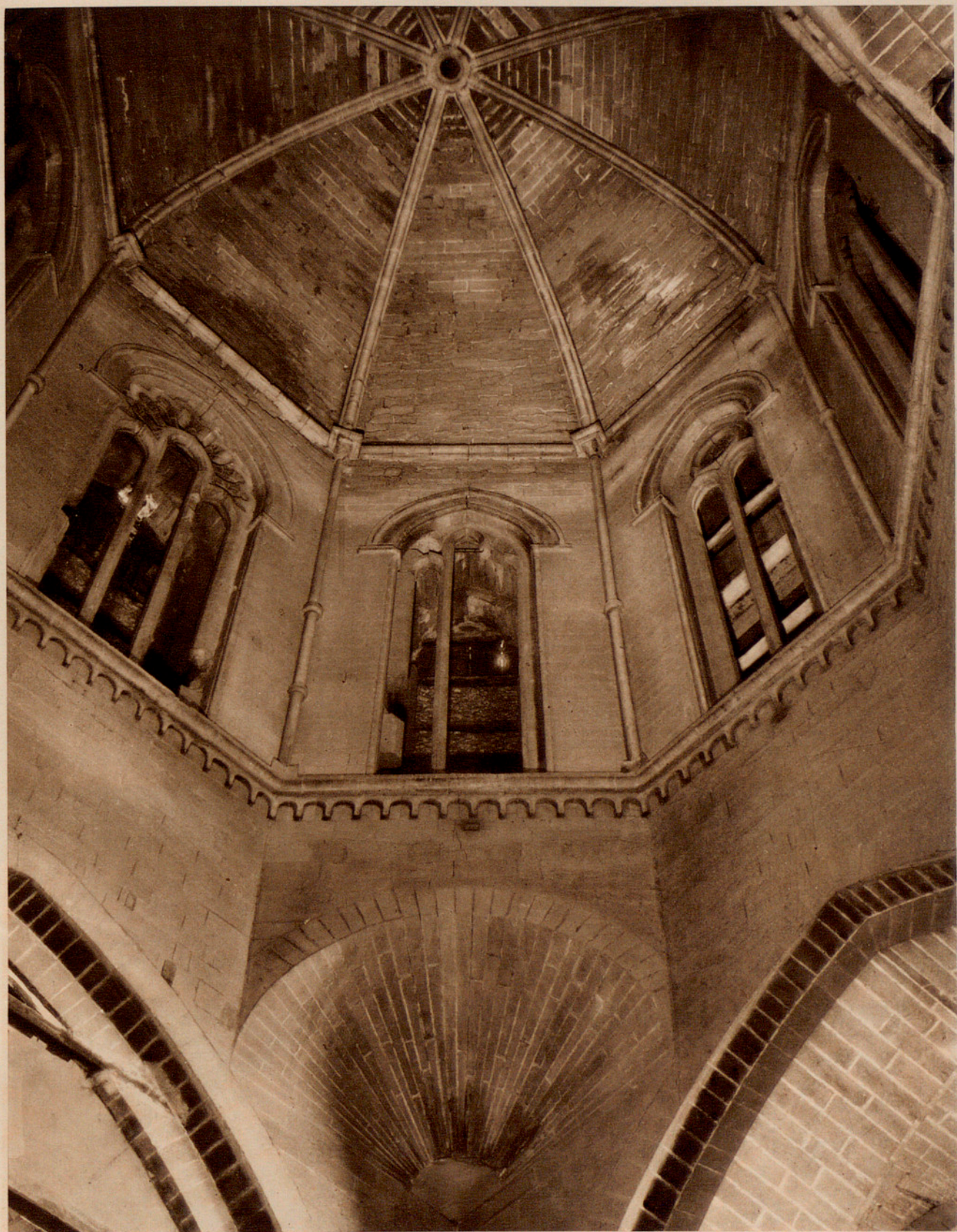
Fig. 157. — INTERIOR DEL CIMBORIO DE LA CATEDRAL VIEJA DE LÉRIDA.
