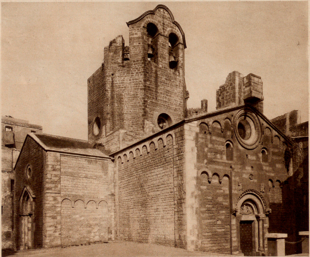
Fig. 146. — CONJUNTO EXTERIOR DE LA IGLESIA DE SAN PABLO DEL CAMPO, BARCELONA.
