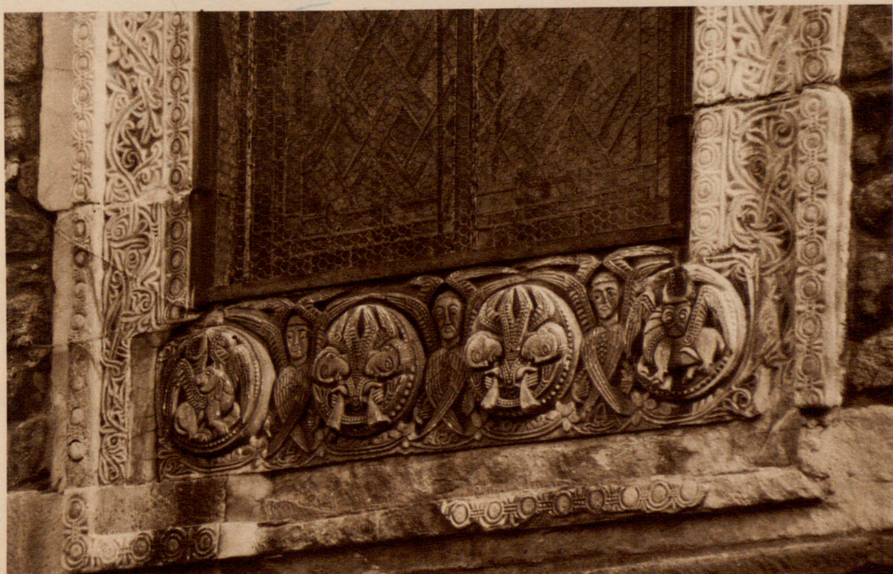
Fig. 13.—DETALLE DE LA VENTANA EN LA FACHADA DE LA IGLESIA DE SAN ANDRÉS DE SUREDA (ROSELLÓN).
