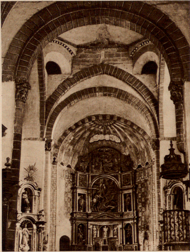
Fig. 234.—INTERIOR DE LA IGLESIA DE AZUELO (NAVARRA). (Foto Uranga.)
