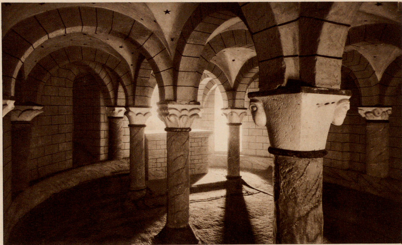
Fig. 254.—CRIPTA DE LA IGLESIA DE SAN MARTÍN DE UNX (NAVARRA).
