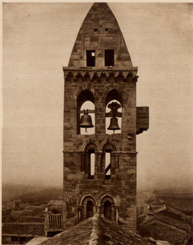
Fig. 439. — TORRE DE LA IGLESIA DE MOMBUEY (ZAMORA). (Foto Ferrant.)
