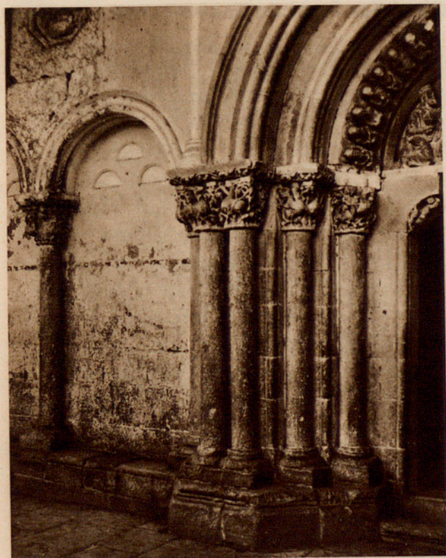
Fig. 398.—DETALLE DE LA PORTADA DE LA IGLESIA DE MORADILLO DE SEDANO (BURGOS). (Photo Club.)
