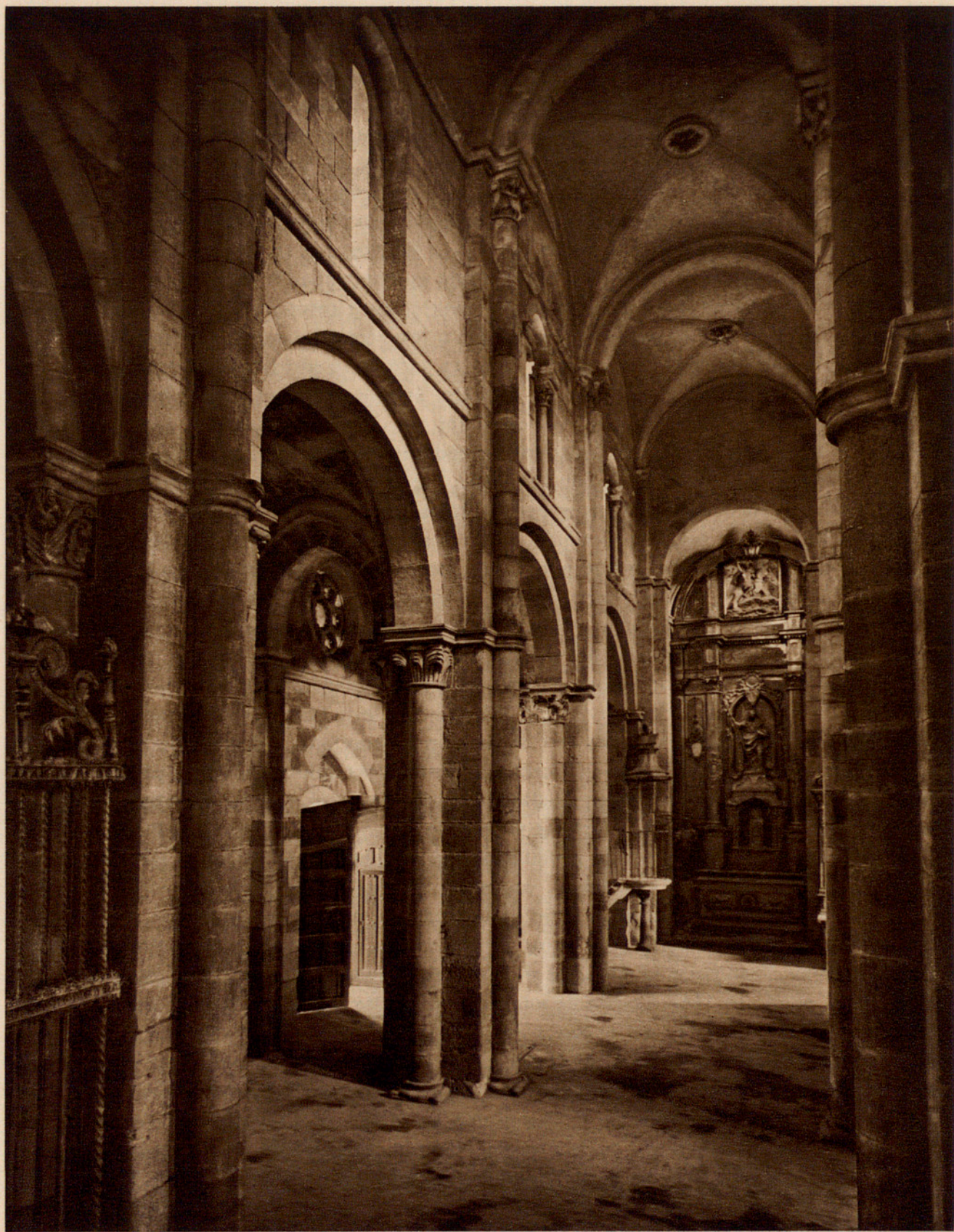
Fig. 429. — INTERIOR DE LA IGLESIA DE SANTIAGO DEL BURGO, ZAMORA. (Foto Ferrant.)
