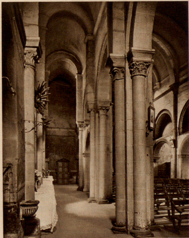
Fig. 516. — INTERIOR DE LA IGLESIA DE SANTA MARÍA DEL CAMPO, LA CORUÑA.
