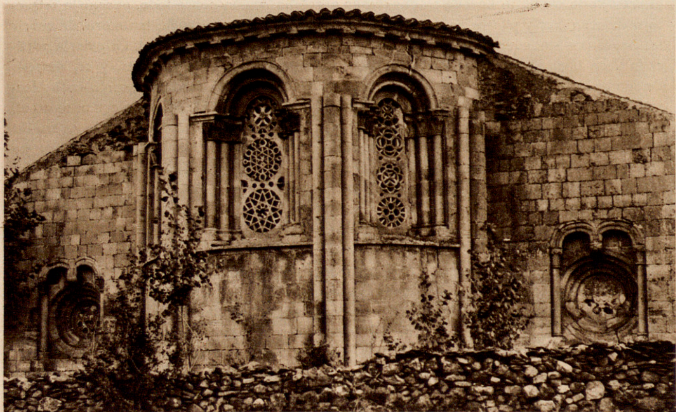
Fig. 467. — CABECERA DE LA IGLESIA DE SANTA COLOMBA, EN ALBENDIEGO (GUADALAJARA). (Foto Layna Serrano.)
