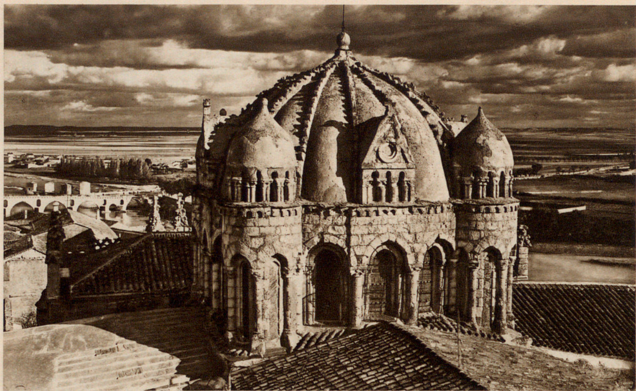
Fig. 414. — EXTERIOR DE LA CÚPULA DE LA CATEDRAL DE ZAMORA. (Foto Lladó.)
