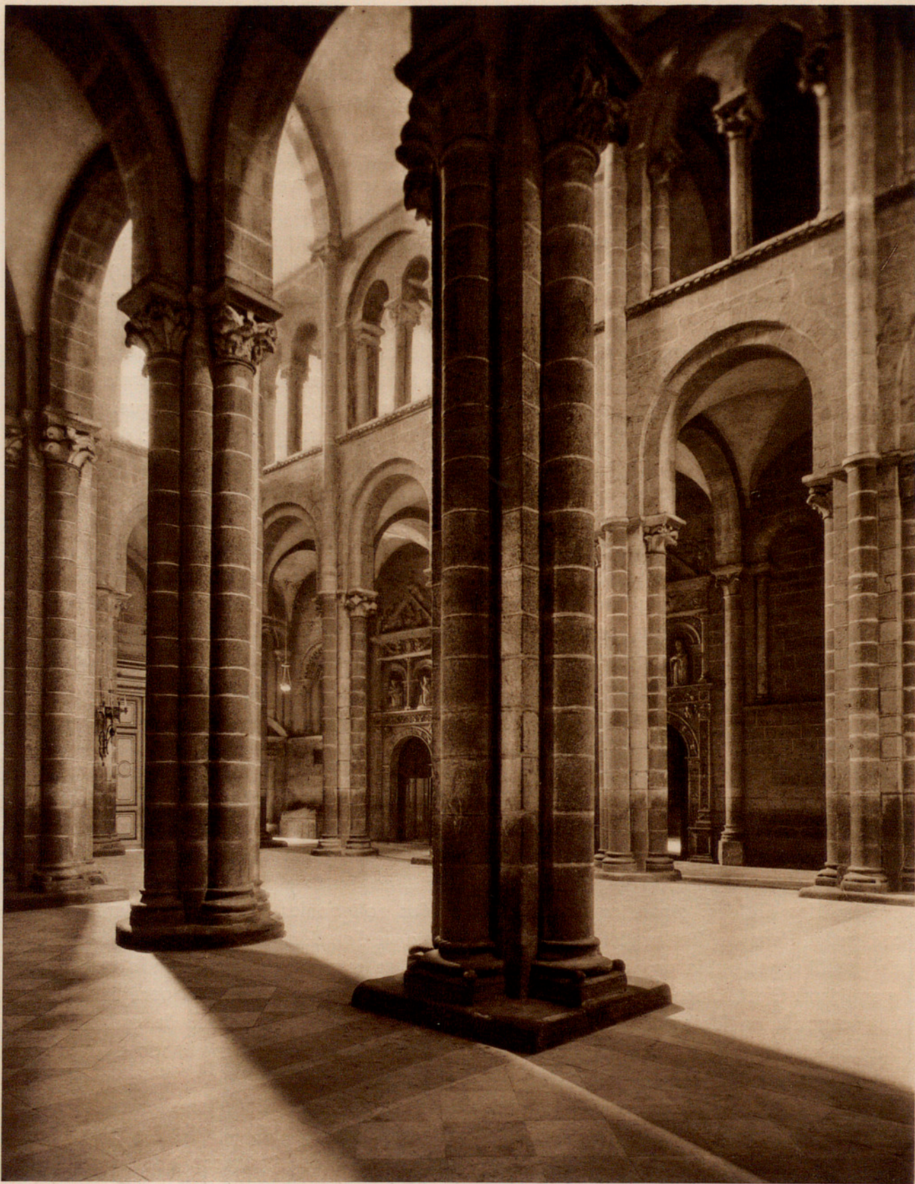
Fig. 345. — ALA SUR DEL CRUCERO DE LA CATEDRAL DE SANTIAGO DE COMPOSTELA.
