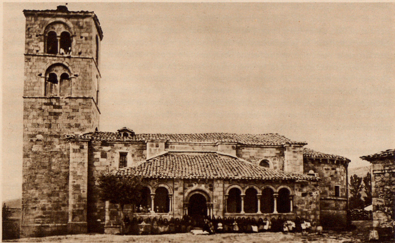
Fig. 459. — EXTERIOR DE LA IGLESIA DE JARAMILLO DE LA FUENTE (BURGOS). (Photo Club.)
