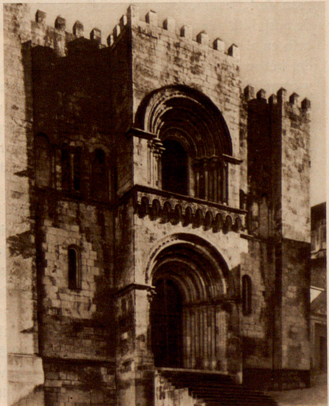
Fig. 531. — FACHADA PRINCIPAL DE LA CATEDRAL DE COIMBRA (PORTUGAL).
