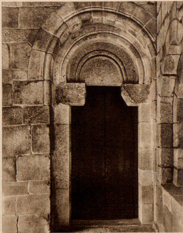
Fig. 538. — PUERTA DE COMUNICACIÓN ENTRE EL CLAUSTRO Y LA IGLESIA DE CETE (PORTUGAL).
