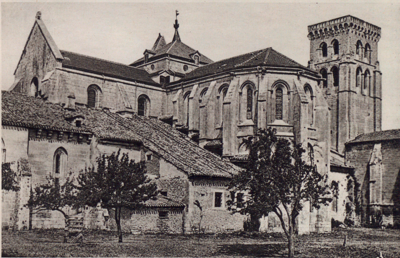
Figs. 63 y 64. — EXTERIOR DE LA CABECERA DE VALÉNCIA. CABECERA DE LA IGLESIA DEL MONASTERIO DE LAS HUELGAS DE BURGOS.
