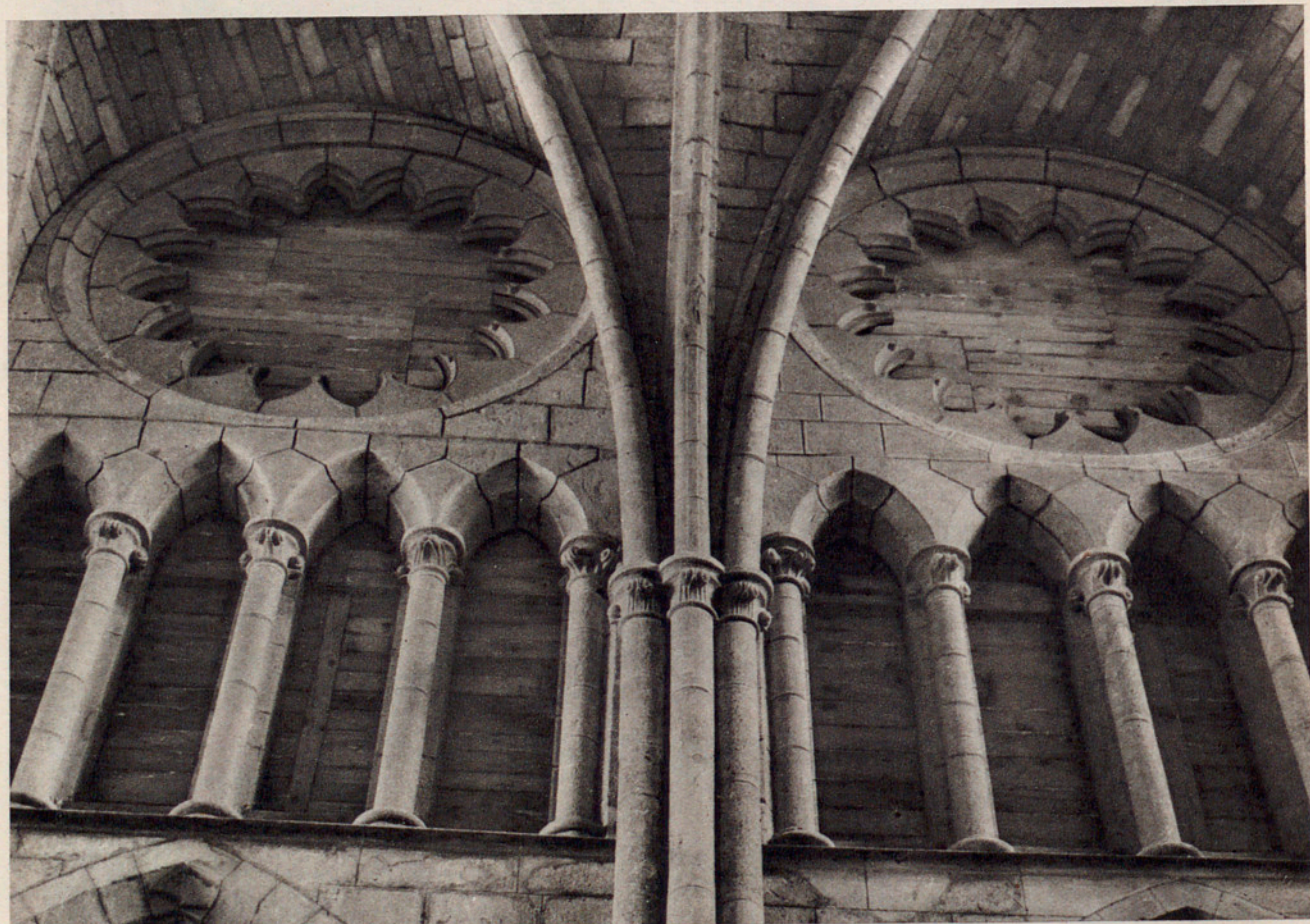
Figs. 26, 27 y 28. — INTERIOR DE LA IGLESIA DE LA HOSPEDERÍA DE RONCESVALLES, DESPUÉS DE LA RECIENTE RESTAURACIÓN.
