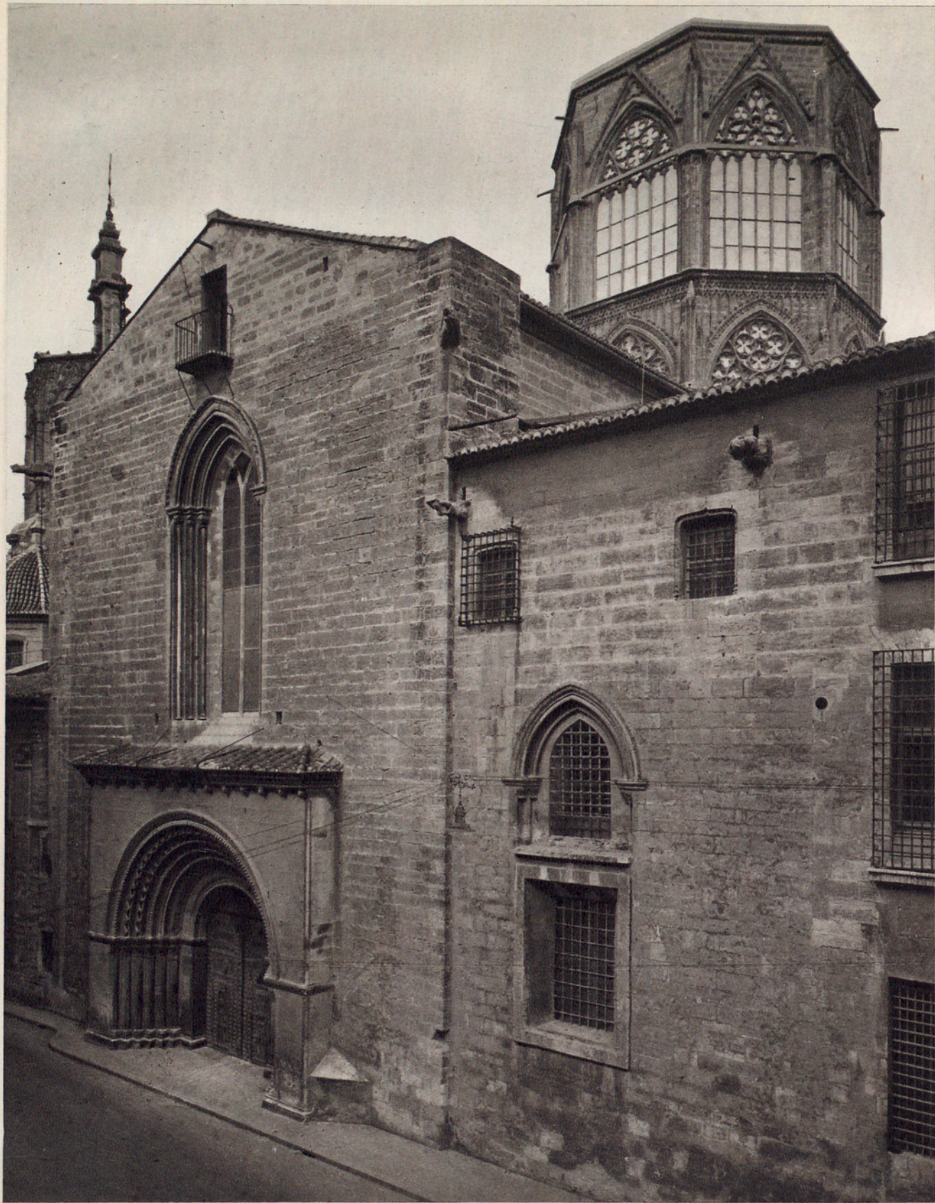
Fig. 61. — FACHADA MERIDIONAL DE LA NAVE DEL CRUCERO Y PUERTA DEL PALAU DE LA CATEDRAL DE VALENCIA.
