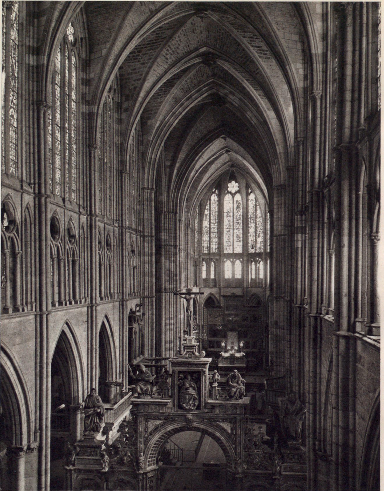
Fig. 59. — NAVE PRINCIPAL DE LA CATEDRAL DE LEÓN.
