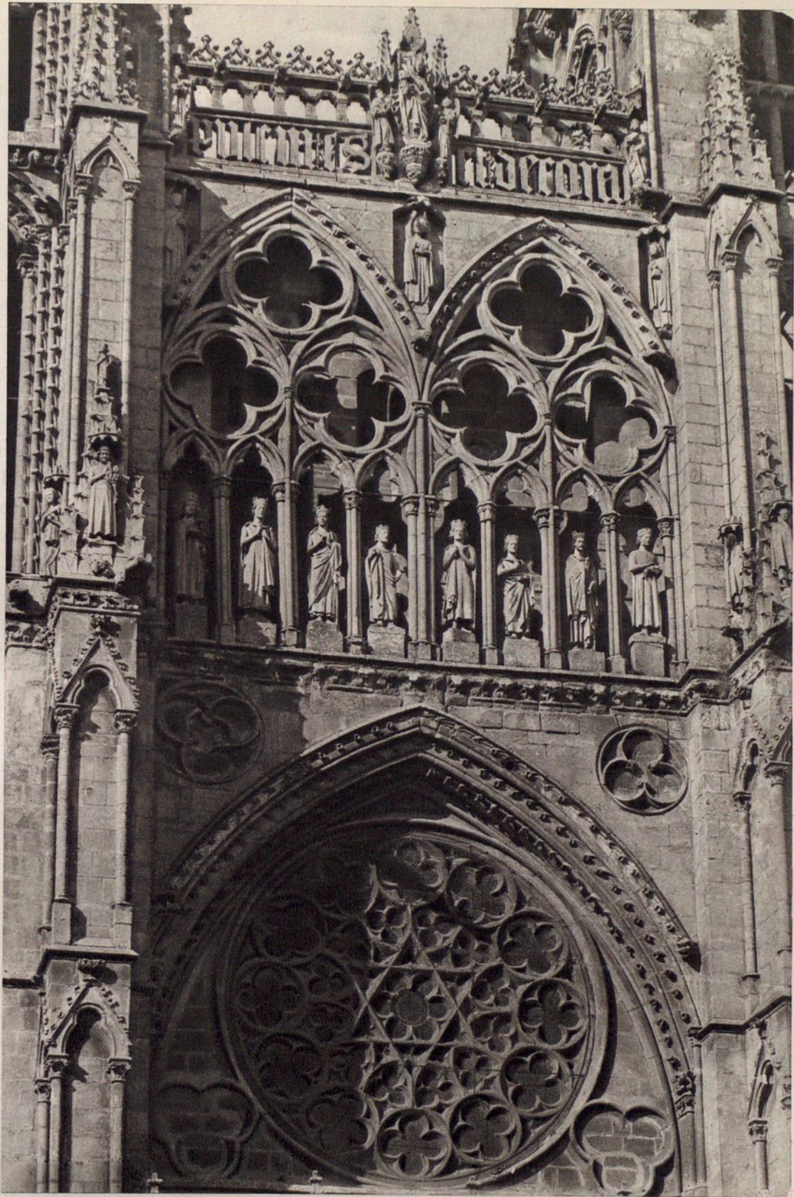
Fig. 43. — PARTE ALTA DE LA FACHADA OCCIDENTAL DE LA CATEDRAL DE BURGOS.
