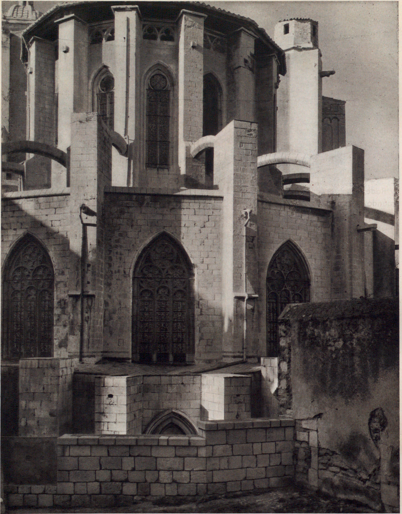
Fig. 159.— EXTERIOR DE LA CABECERA DE LA CATEDRAL DE GERONA.
