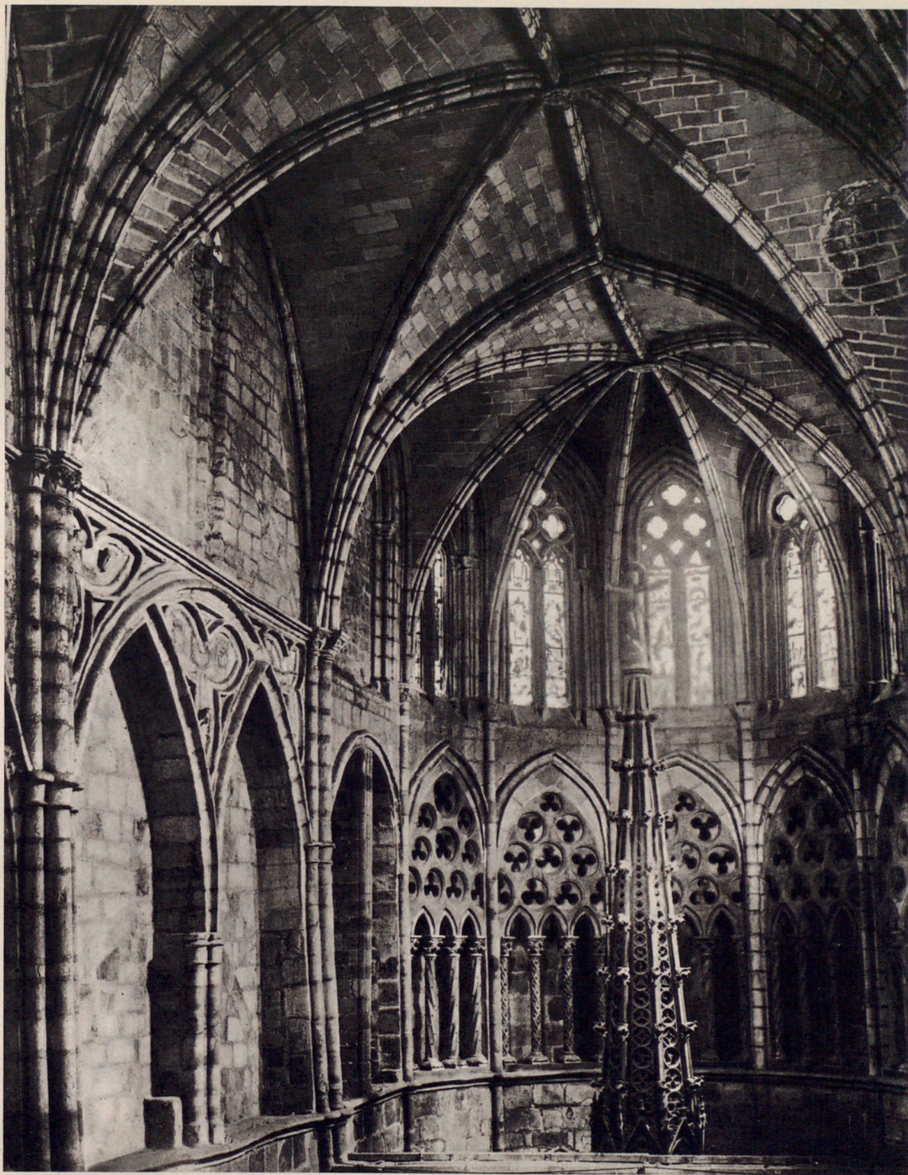
Fig. 136. — INTERIOR DE LA CABECERA DE LA IGLESIA DE SANTA MARÍA DE CASTRO URDIALES.
