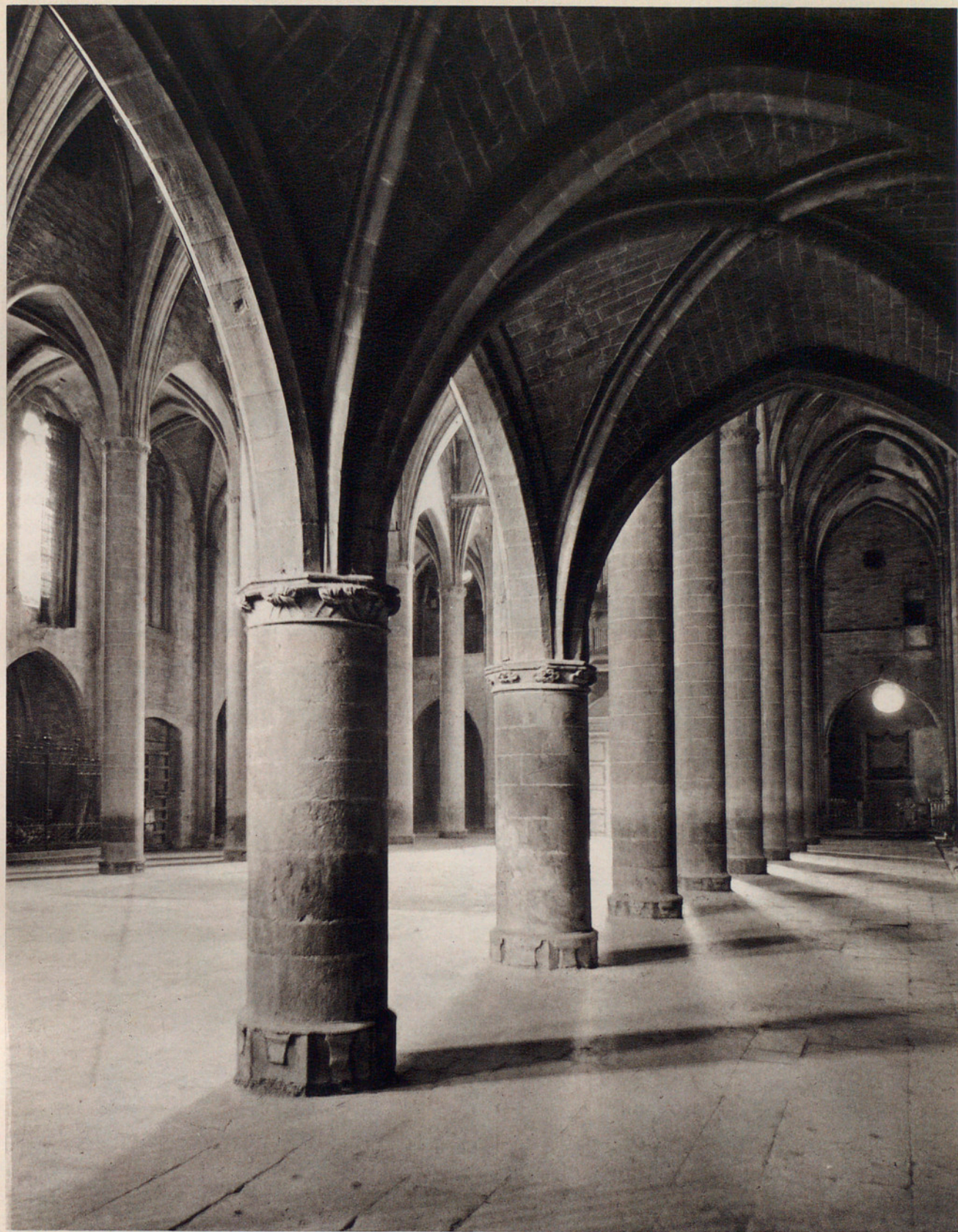
Fig. 166.— INTERIOR DE SANTA MARÍA DE CASTELLÓN DE AMPURIAS.
