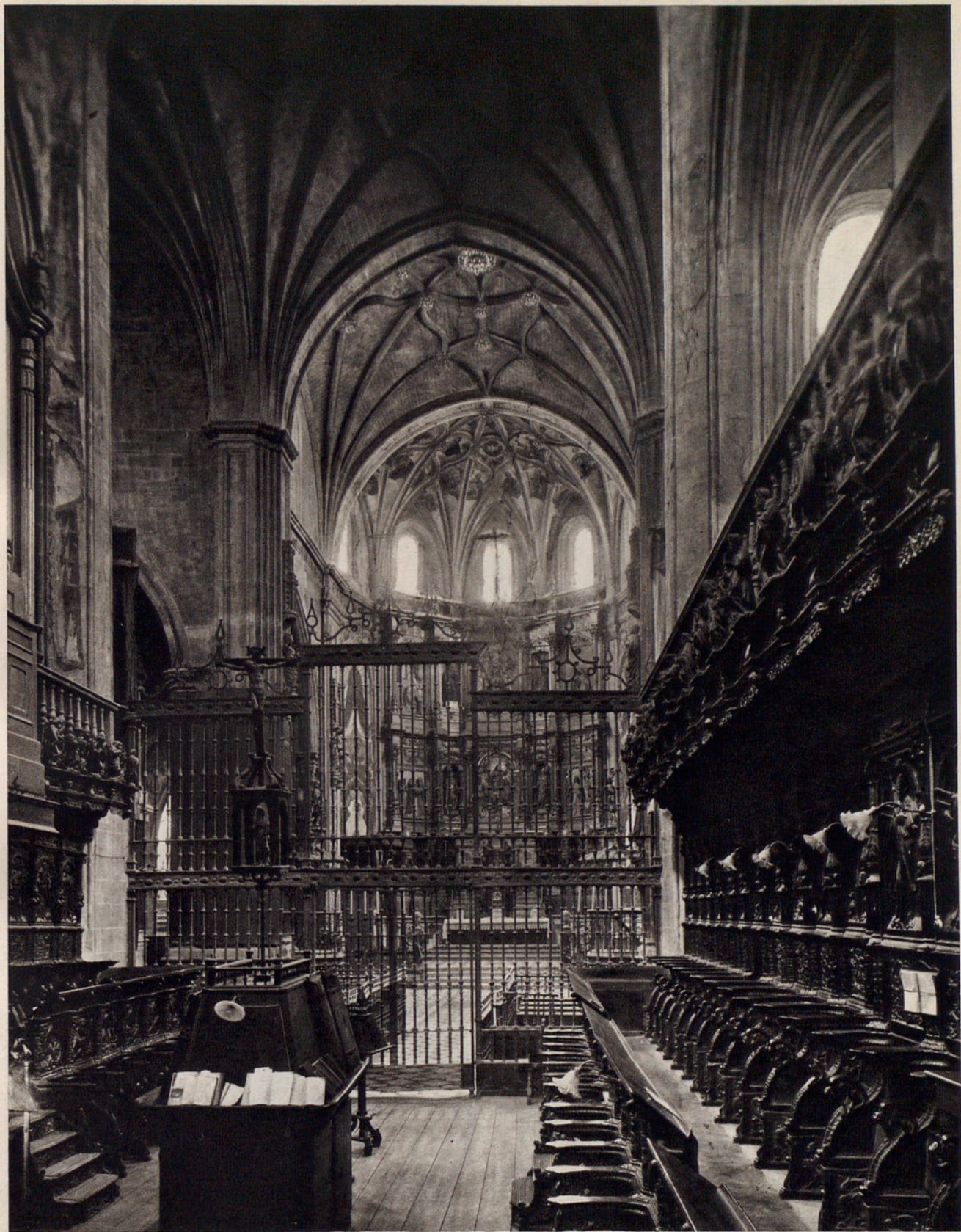
Fig. 240.— INTERIOR DE LA CATEDRAL DE CALAHORRA.
