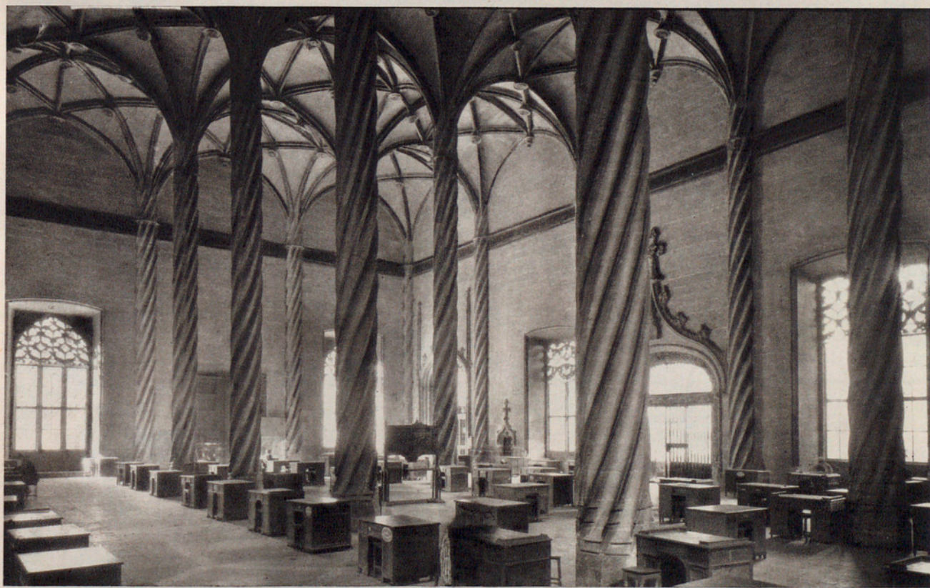
Figs. 301 y 302. — EXTERIOR E INTERIOR DE LA LONJA DE VALENCIA.
