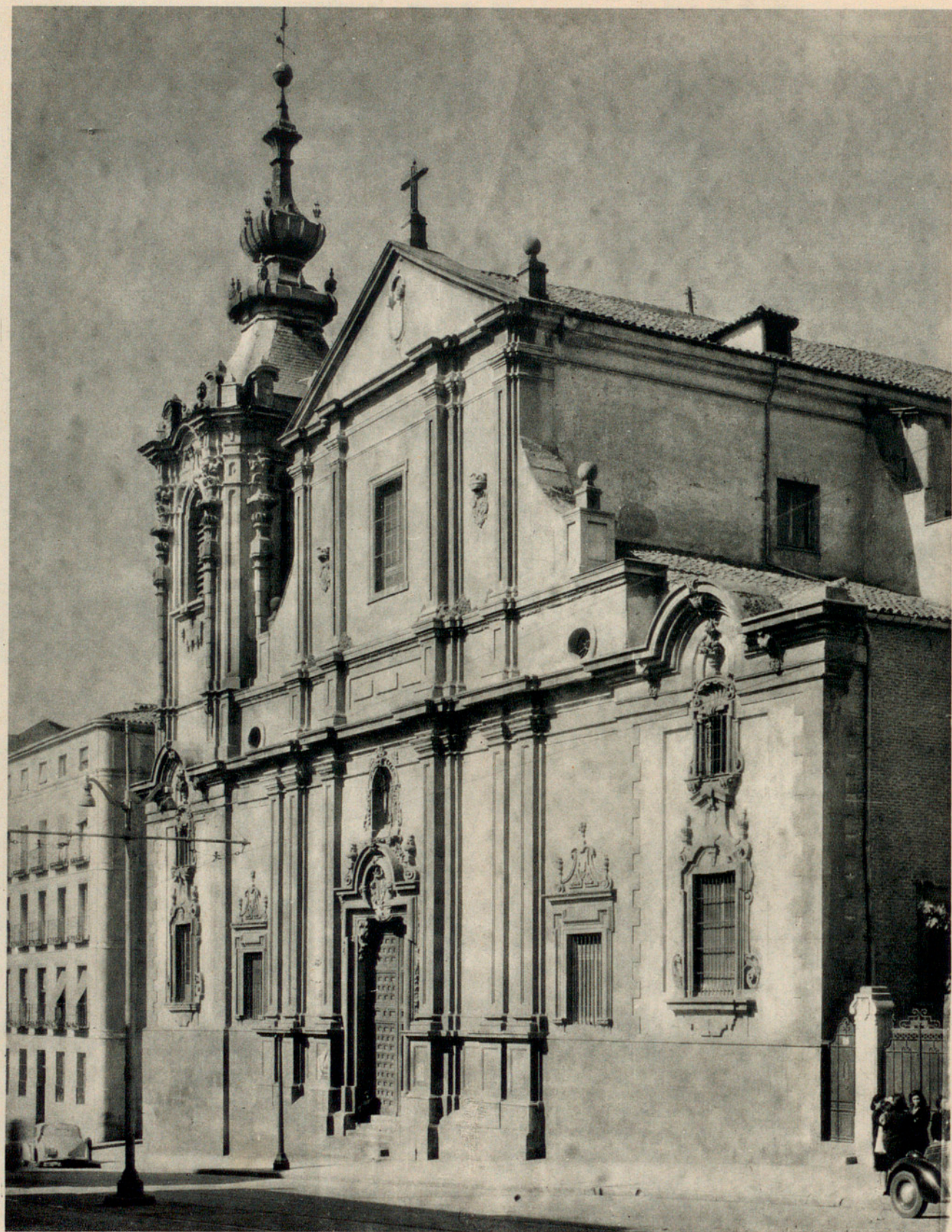
Fig. 226.—MADRID: FACHADA DE LA IGLESIA DE MONTSERRAT.
