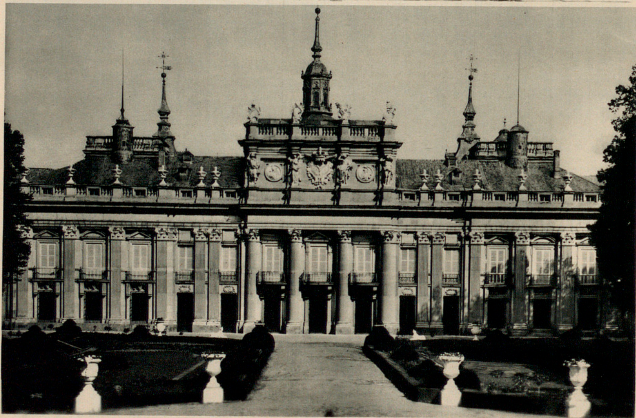
Figs. 258 y 259.—LA GRANJA: VISTA AÉREA Y FACHADA PRINCIPAL DEL PALACIO AL JARDÍN.
