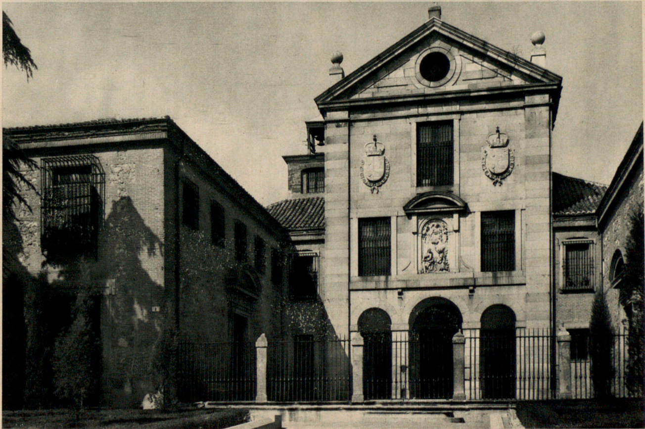
Figs. 58, 59 y 60.—SEVILLA: INTERIOR DE LA CAPILLA DE LA UNIVERSIDAD. SALAMANCA: DETALLE DE LA CLERECIA. MADRID: FACHADA DEL CONVENTO DE LA ENCARNACION.
