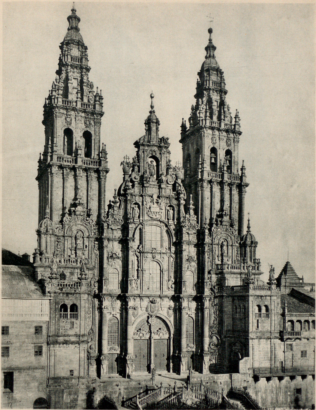
Fig. 136.—SANTIAGO DE COMPOSTELA: FACHADA DEL OBRADOIRO. EN LA CATEDRAL.
