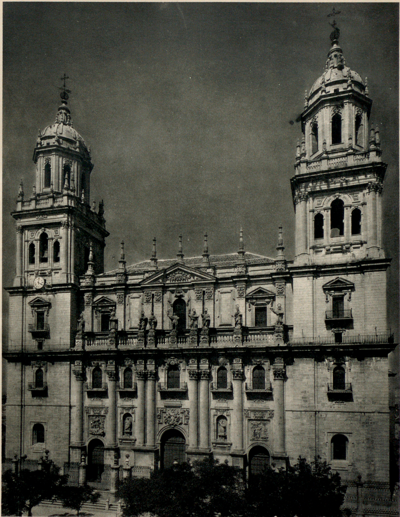
Fig. 115.—JAÉN: FACHADA PRINCIPAL DE LA CATEDRAL.
