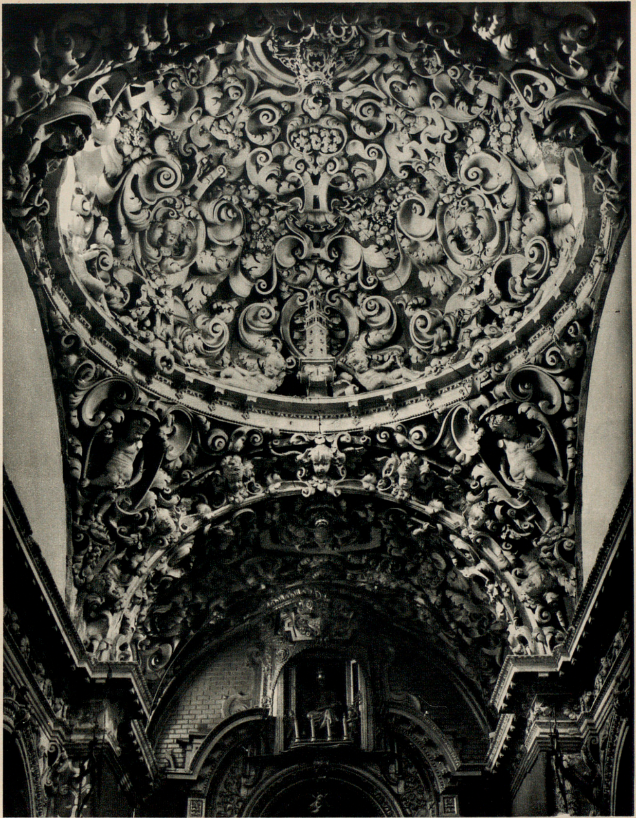
Fig. 49.—SEVILLA: INTERIOR DE LA IGLESIA DE SANTA MARÍA LA BLANCA.
