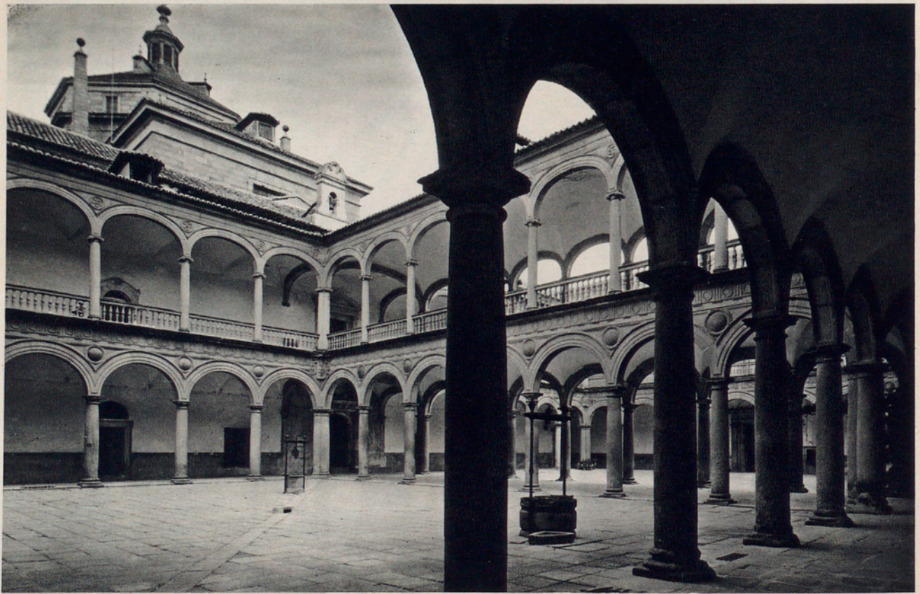
Figs. 138 y 139.—FACHADA PRINCIPAL DEL ALCÁZAR DE TOLEDO. PATIO DEL HOSPITAL DE AFUERA, EN LA MISMA CIUDAD.
