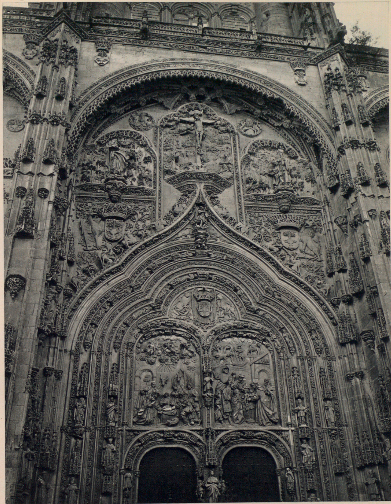
Fig. 67. — FACHADA DEL NACIMIENTO EN LA CATEDRAL NUEVA DE SALAMANCA.
