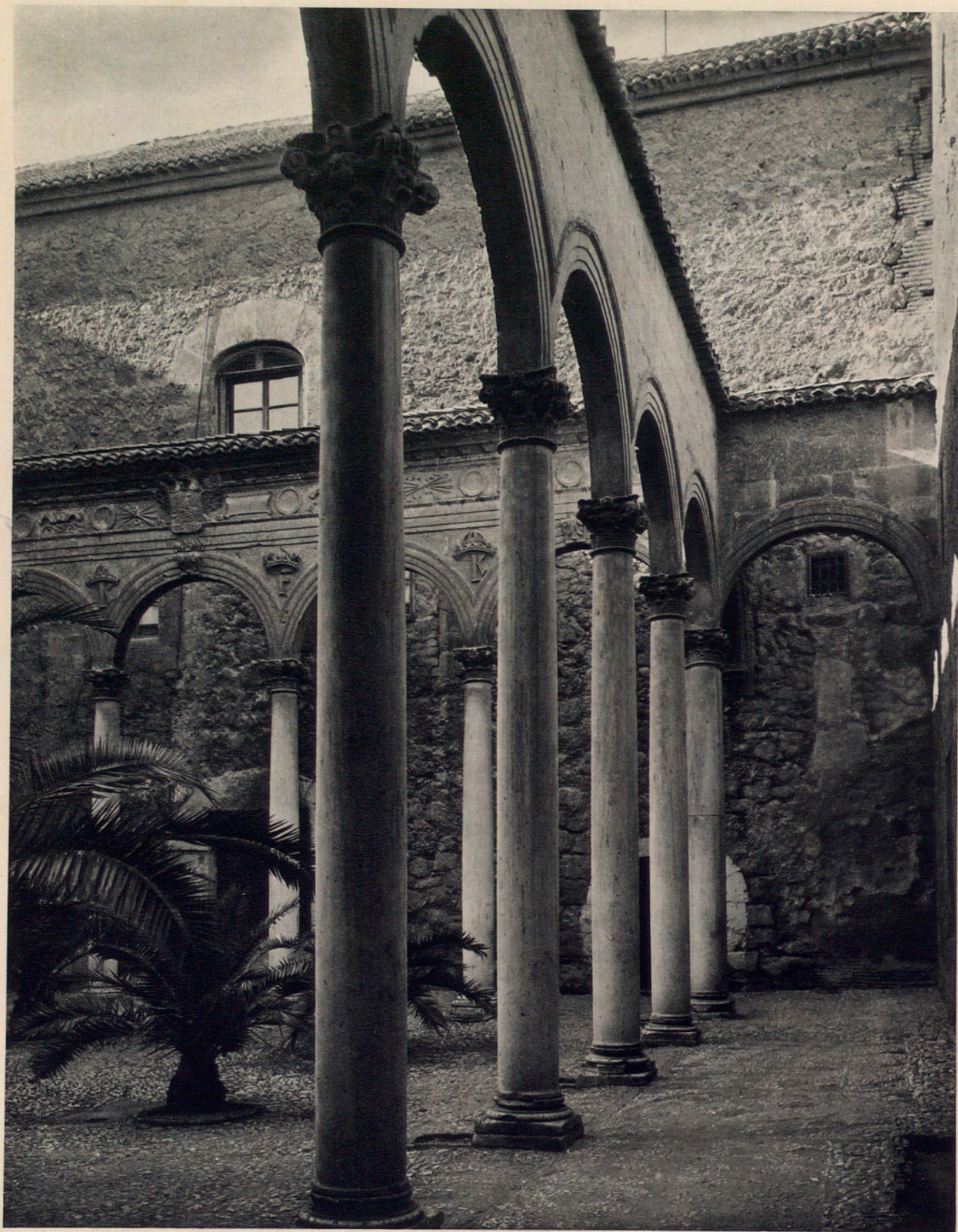
Fig. 26. — PATIO INACABADO DEL HOSPITAL REAL DE GRANADA.
