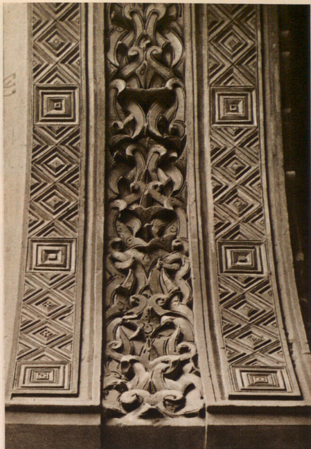
Fig. 39. — DECORACIÓN DE YESO EN EL INTRADÓS DE UN ARCO DE LA PUERTA DEL PERDÓN DE LA CATEDRAL DE SEVILLA.
