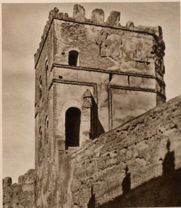
Fig. 25. — TORRE LLAMADA BLANCA DE LA CERCA DE SEVILLA.
