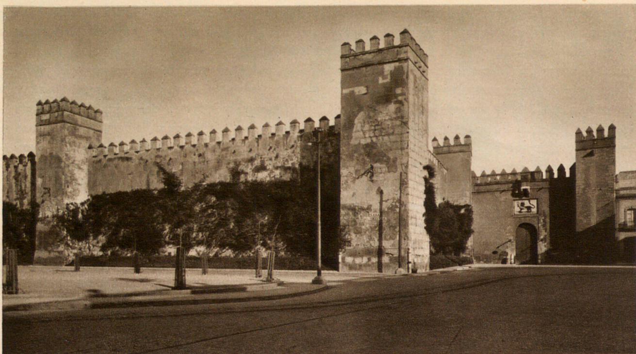
Fig. 17. — MURALLAS Y TORRES DEL RECINTO DEL ALCÁZAR DE SEVILLA.
