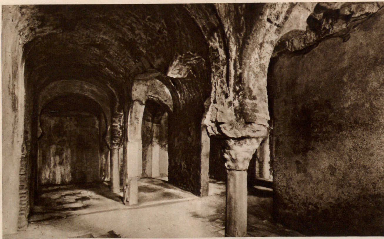
Fig. 148. — INTERIOR DEL BAÑO DE RONDA (MÁLAGA).
