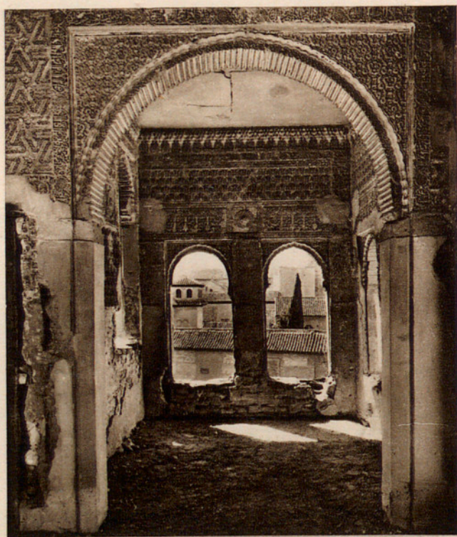
Fig. 115.—INTERIOR DEL MIRADOR ALTO DEL PARTAL DE LA ALHAMBRA.
