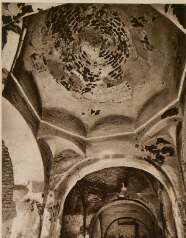
Fig. 74.— CÚPULA EN EL INTERIOR DE LA TORRE DEL HOMENAJE DE LA ALHAMBRA.
