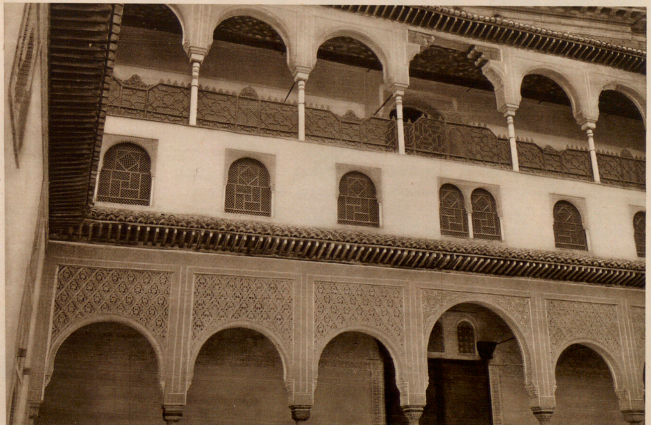
Figs. 84 y 85.— PATIO DE COMARES O DE LA ALBERCA. FRENTE MERIDIONAL DEL PATIO DE COMARES EN LA CASA REAL VIEJA DE LA ALHAMBRA.
