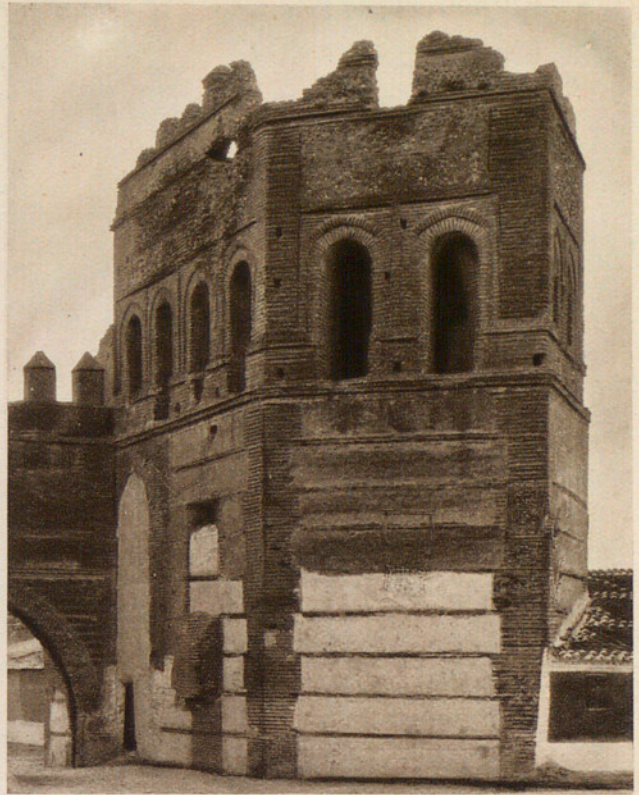
Fig. 382. — TORREÓN EN LA PUERTA DE CANTALAPIEDRA DEL RECINTO DE MADRIGAL (ÁVILA).
