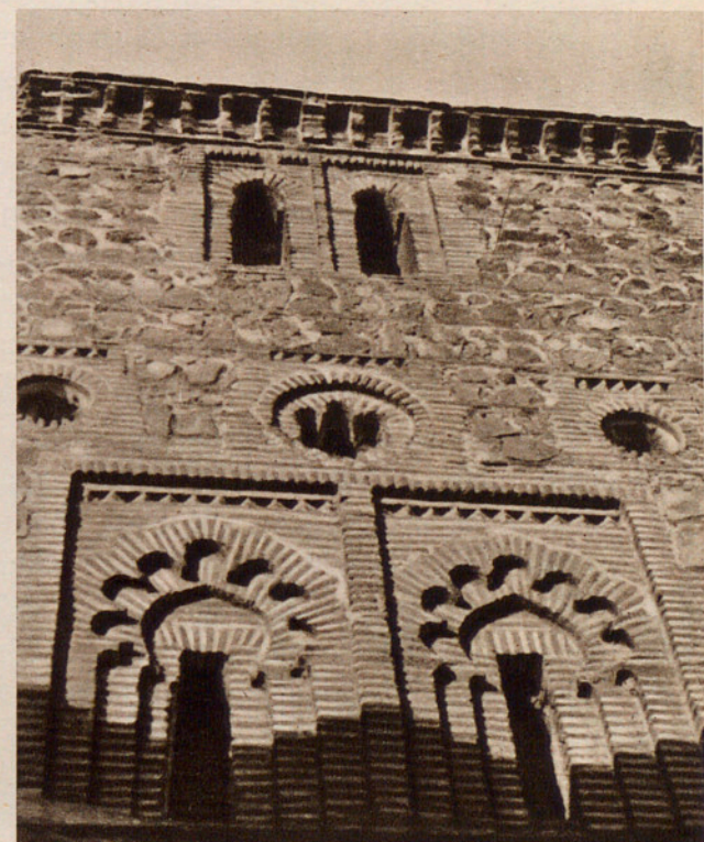
Fig. 268. — DETALLE DEL HASTIAL DE LOS PIES DE LA IGLESIA DE SANTIAGO, EN TALAVERA DE LA REINA (TOLEDO).
