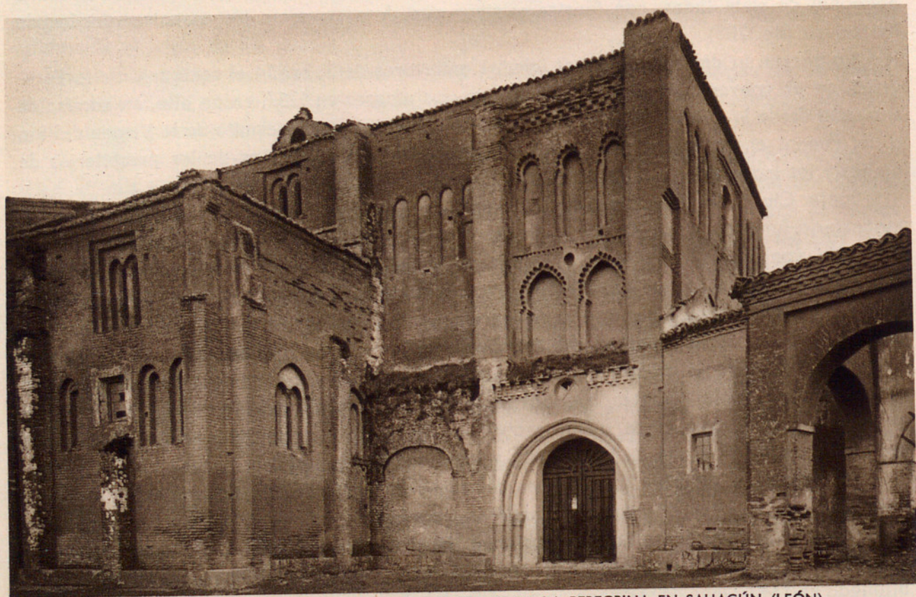
Fig. 290. — EXTERIOR DE LA IGLESIA DEL CONVENTO DE LA PEREGRINA EN SAHAGÚN (LEÓN).
