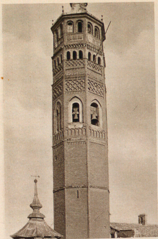
Fig. 310. — TORRE DE SAN PABLO, EN ZARAGOZA.
