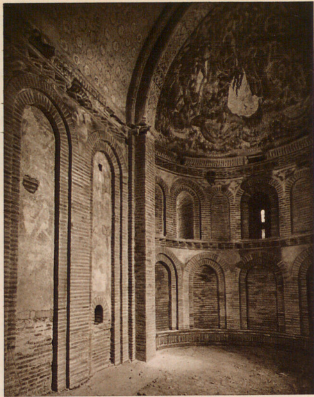
Fig. 275.— INTERIOR DE LA IGLESIA DEL CRISTO DE LAS BATALLAS DE TORO (ZAMORA).
