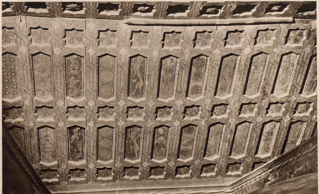
Fig. 403. — DETALLE DE UNO DE LOS FALDONES DE LA TECHUMBRE DE LA NAVE MAYOR DE LA CATEDRAL DE TERUEL.
