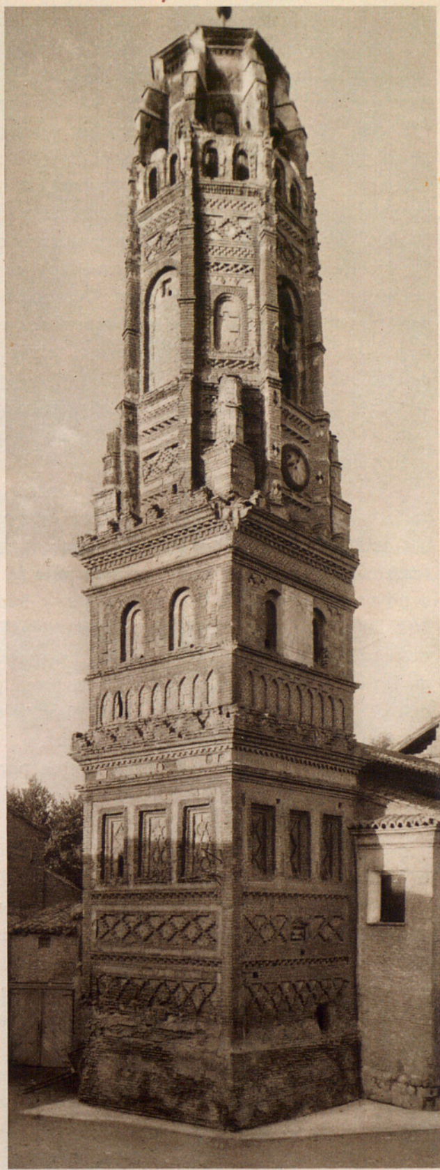
Fig. 314. — TORRE DE LA IGLESIA DE UTEBO (ZARAGOZA).
