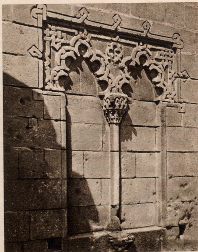
Fig. 410. — VENTANA CIEGA EN LA TORRE DE SAN DIONISIO, EN JEREZ DE LA FRONTERA (CÁDIZ).
