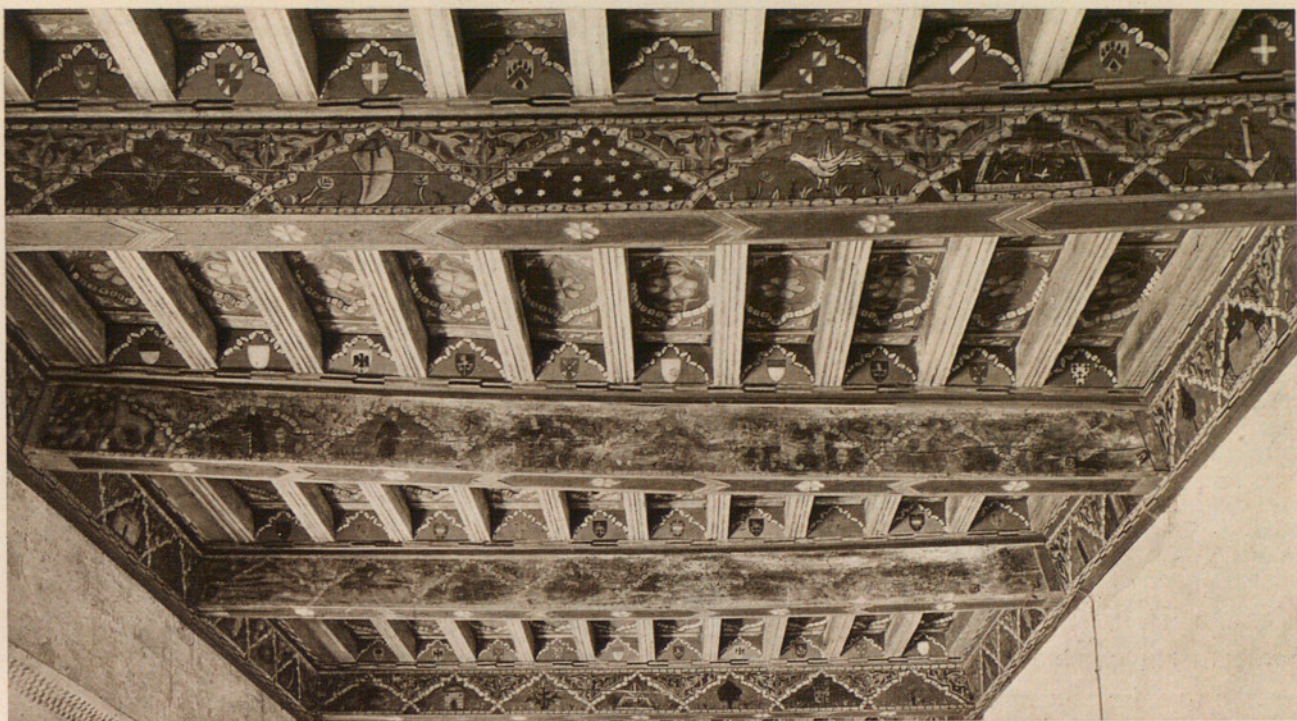
Fig. 399.— ALFARJE EN EL CLAUSTRO DEL MONASTERIO DE SANTO DOMINGO DE SILOS (BURGOS).
