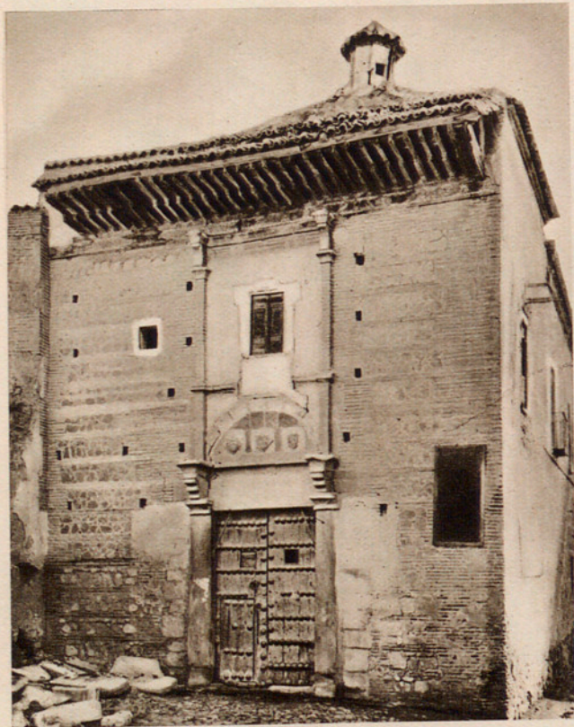
Fig. 360. — FACHADA DEL LLAMADO PALACIO DEL REY DON PEDRO, EN TOLEDO.
