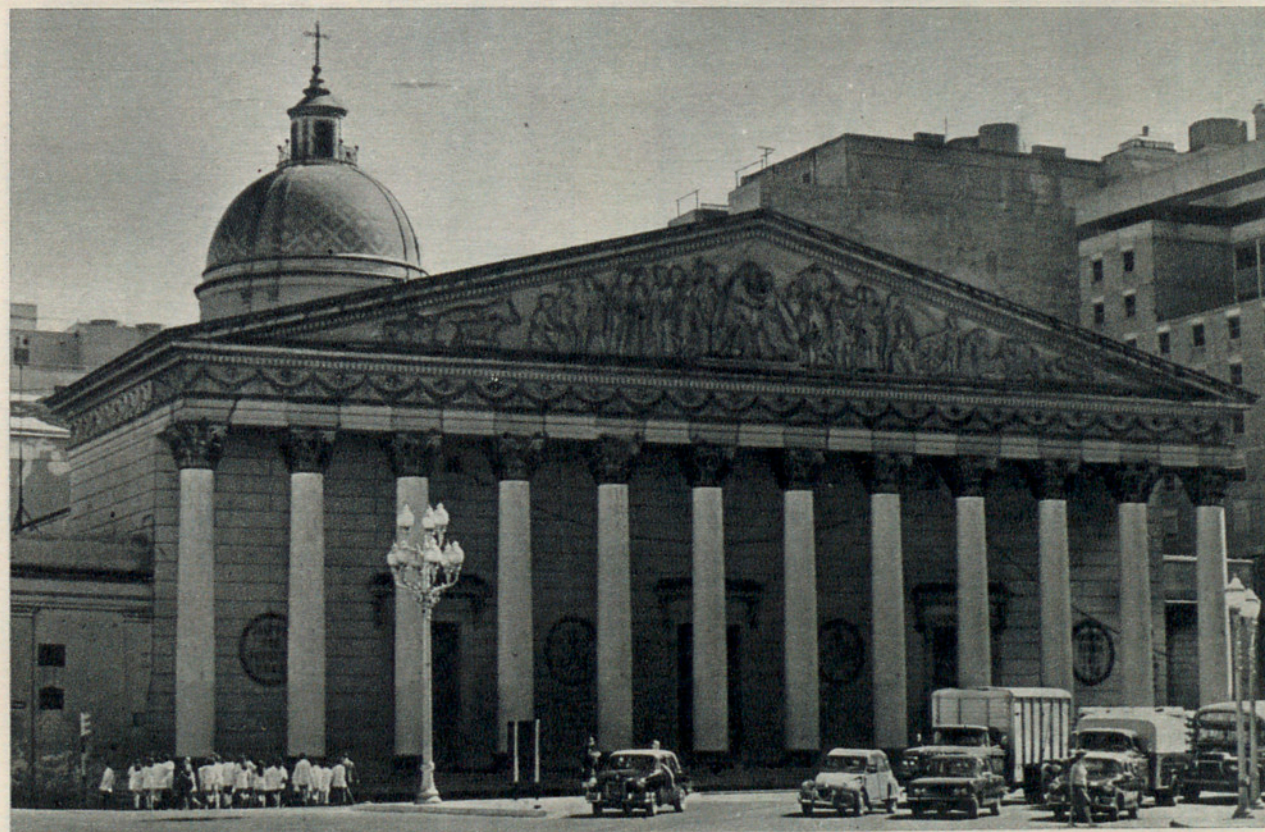
Fig. 626.—CATEDRAL DE BOGOTÁ, ANTES DE 1947. Fig. 627.—CATEDRAL DE MONTEVIDEO. Fig. 628.—FACHADA DE LA CATEDRAL DE BUENOS AIRES.
