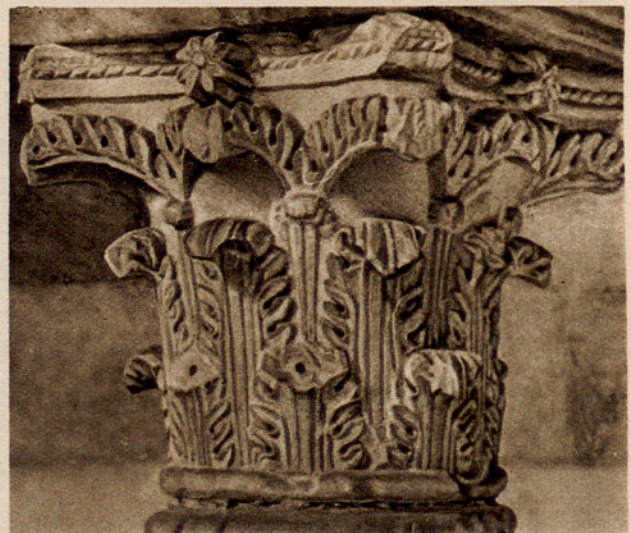
Figs. 53 a 55. — CAPITELES DE LA MISMA AMPLIACIÓN.
