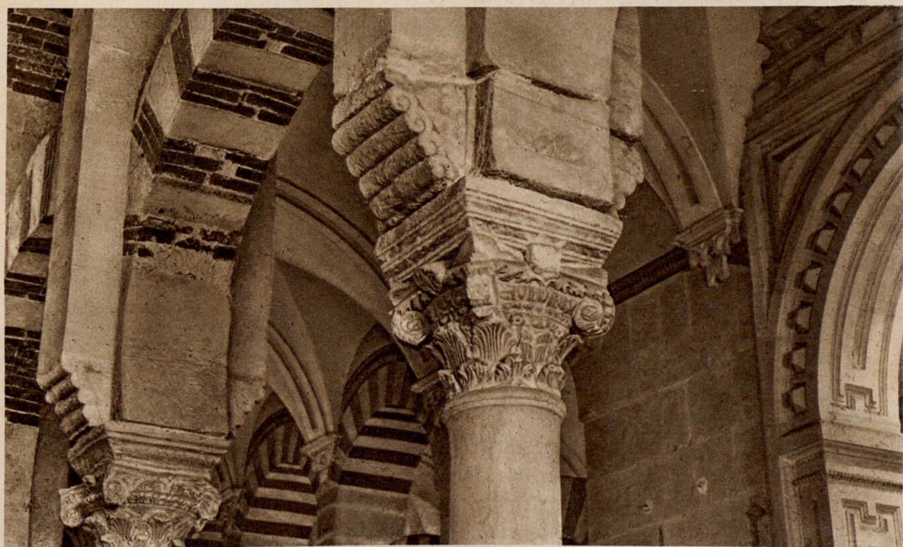
Fig. 33. — ARRANQUES DE LAS ARQUERÍAS DE LAS NAVES.
