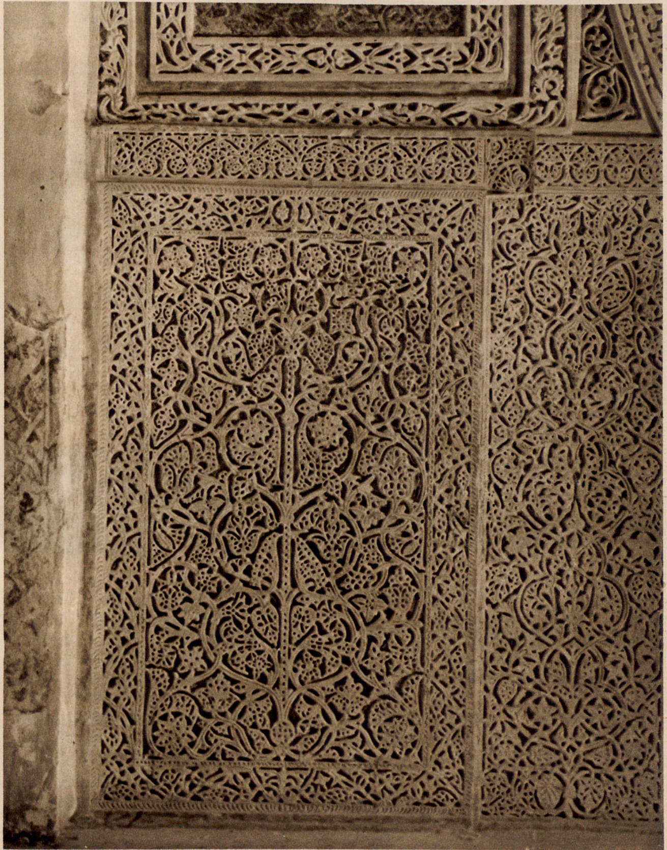
Fig. 176. — JAMBAS DEL ARCO DEL MIHRAB.
