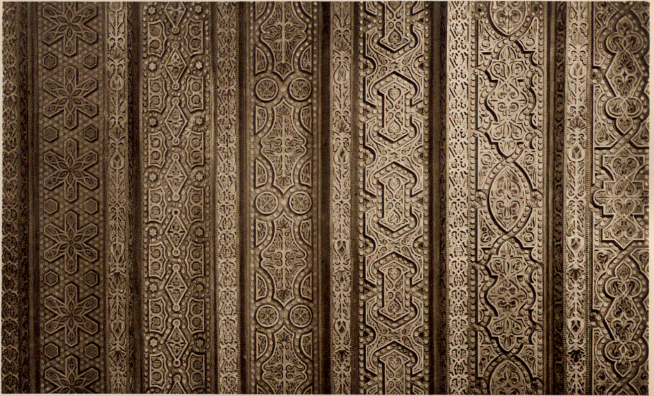
Fig. 134. — TECHO DE LA NAVE MEDIAL DE ALHÁCAM II (RESTAURACIÓN).
