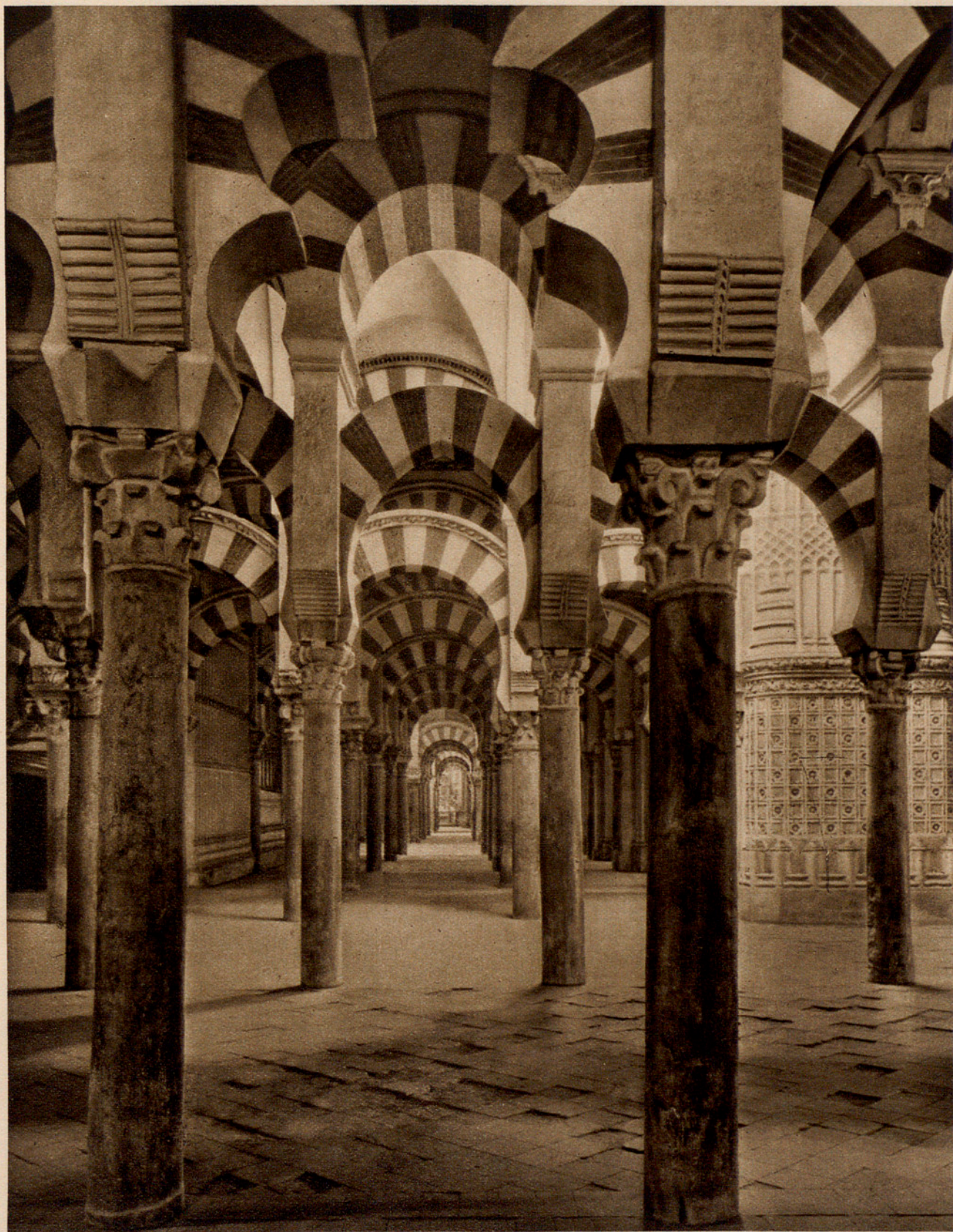
Fig. 215. — TRAMOS CON ARQUERÍAS ANGOSTAS DE LA AMPLIACIÓN DE ALMANZOR.
