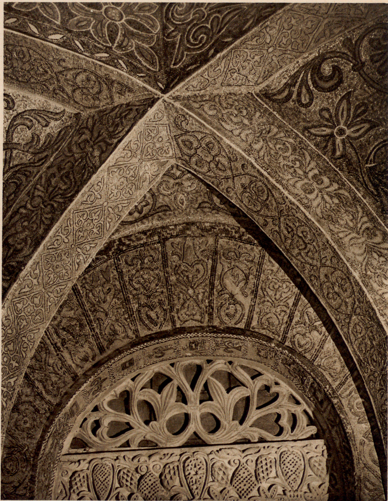
Fig. 171. — ARRANQUE DE LA CÚPULA ANTE EL MIHRAB, CON CELOSÍA.
