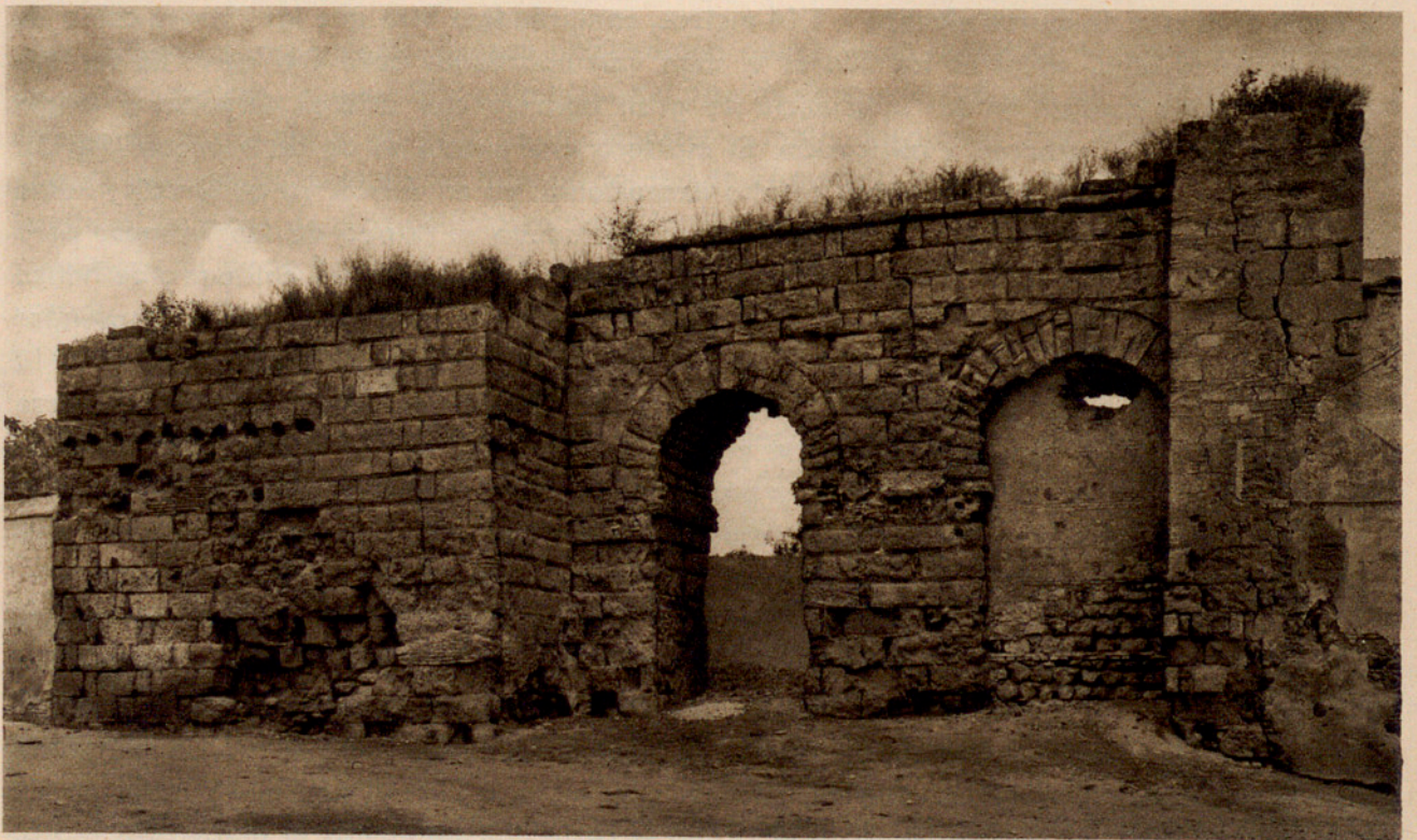
Fig. 4. — ARCOS DE LA PUERTA DE SEVILLA EN CÓRDOBA.
