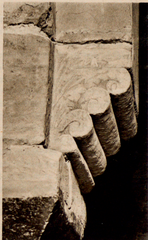
Fig. 40. — MODILLÓN DE LOS PILARES DE LAS NAVES.
