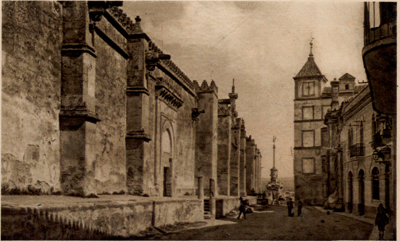
Fig. 12. — FACHADA OCCIDENTAL DE LA MISMA.
