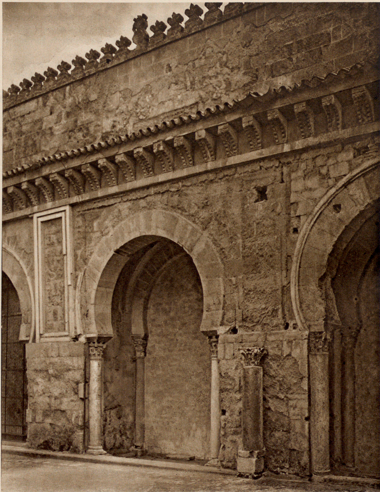
Fig. 96. — FACHADA DEL PATIO DE LA ALGIMA DE CÓRDOBA.
