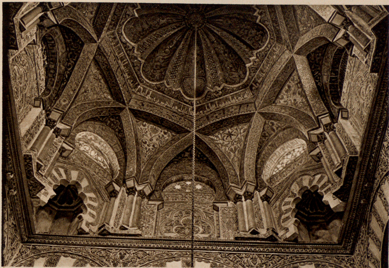
Fig. 161. — ARRANQUES DE LA CÚPULA DE LA CAPILLA DEL MIHRAB.
