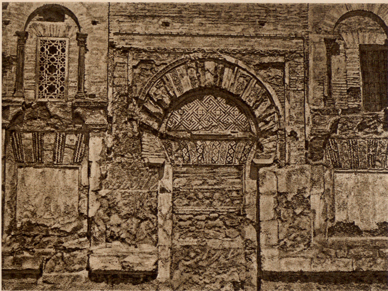
Fig. 199. — OTRA DE LAS PORTADAS DEL LADO OCCIDENTAL, ANTES DE SU RESTAURACIÓN.
