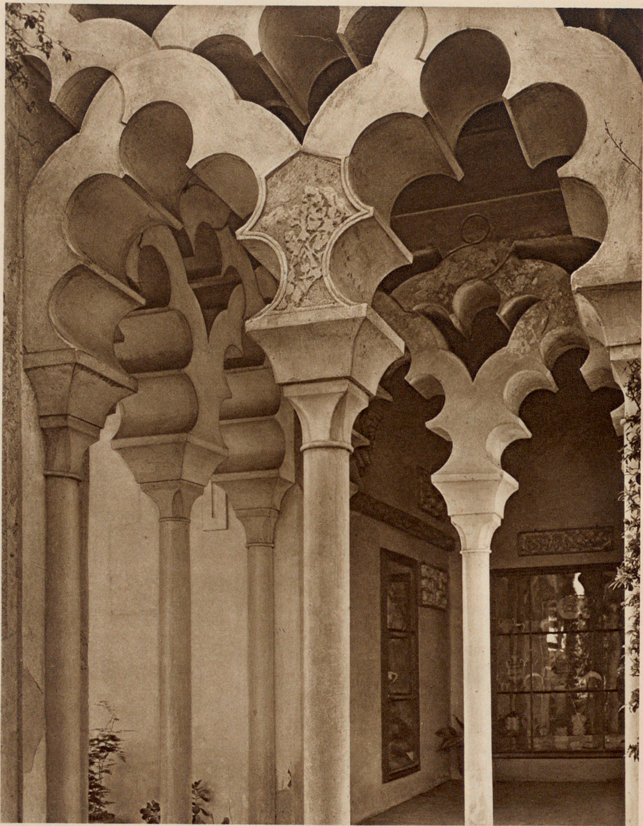
Fig. 306. — PABELLÓN LATERAL DEL PALACIO DE LA ALCAZABA DE MÁLAGA: MUY RESTAURADO.
