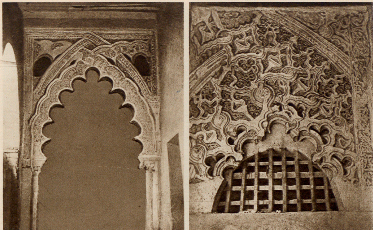
Fig. 294. — ARCOS DEL PÓRTICO MERIDIONAL DEL PATIO DE LA ALJAFERÍA, FOTOGRAFIADOS EN 1866.
