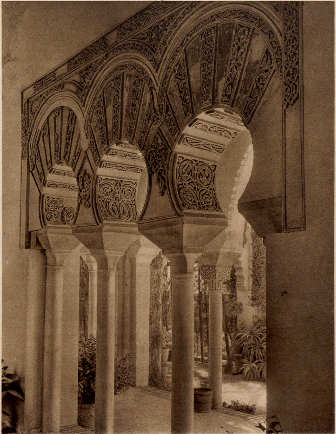
Fig. 303. — ARQUERÍA DEL PALACIO DE LA ALCAZABA, QUE SE LLAMÓ CUARTOS DE GRANADA.
