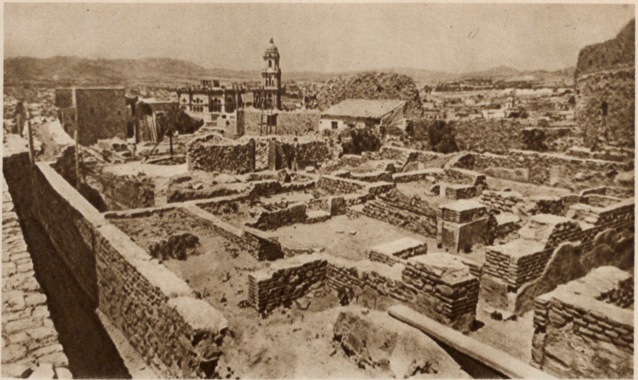
Fig. 308. — RUINAS DE CASAS EN LA ALCAZABA DE MÁLAGA.
