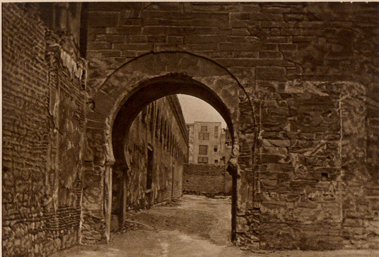
Fig. 254. — PASADIZO DE COMUNICACIÓN ENTRE LA MEZQUITA DE ABENTULÚN Y SU ALMINAR.
