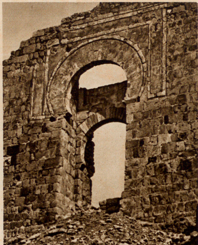
Fig. 239. — PUERTA PRINCIPAL DEL CASTILLO DE GORMAZ.
