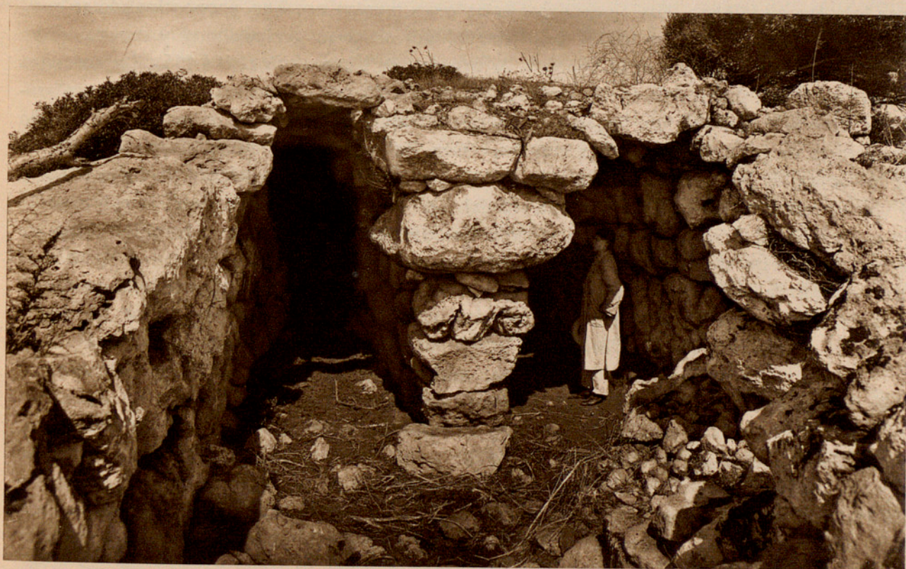
Fig. 113. — RESTOS DEL INTERIOR DE LA NAVETA DE SON MERCÉ DE BAIX, EN FERRERÍAS (MENORCA), EN LA CUAL SE APRECIA EL TÍPICO PILAR BALEÁRICO DE BASE ESTRECHA QUE LUEGO SE ENSANCHA EN SU ALZADO.
