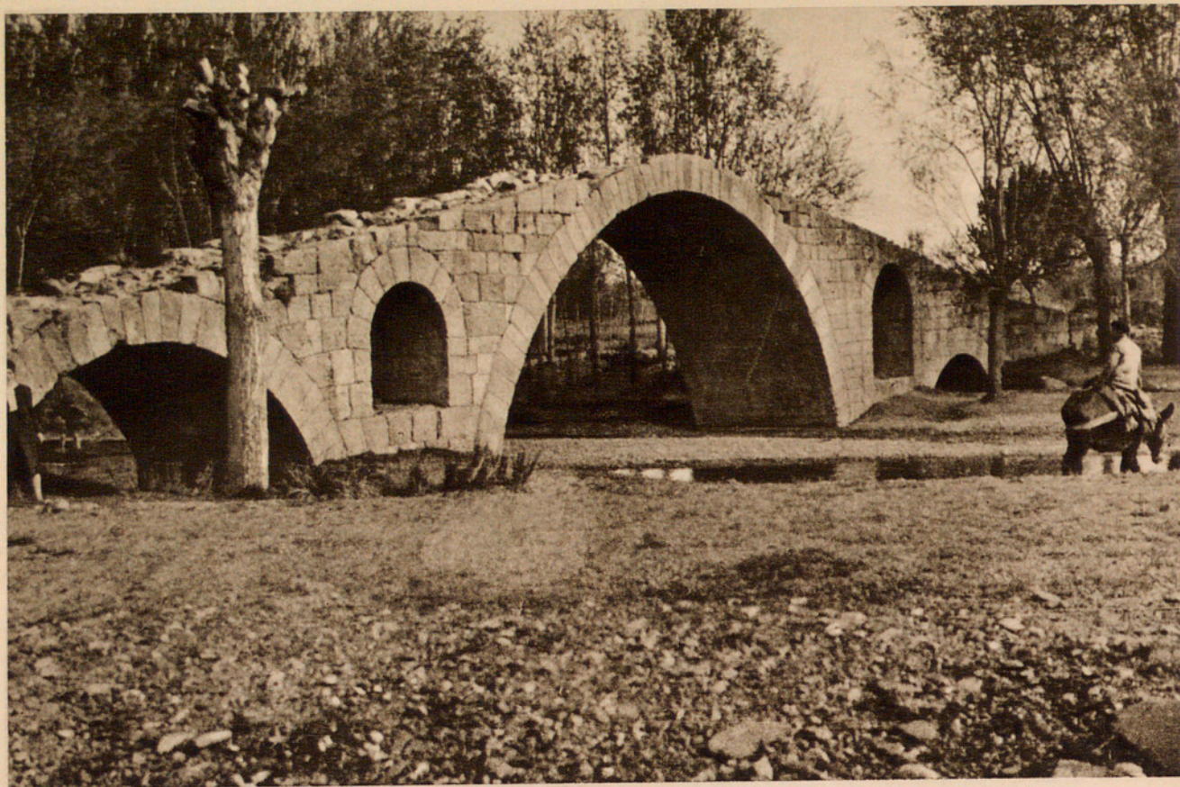
Fig. 2. — PUENTE DE LUCO (TERUEL).
