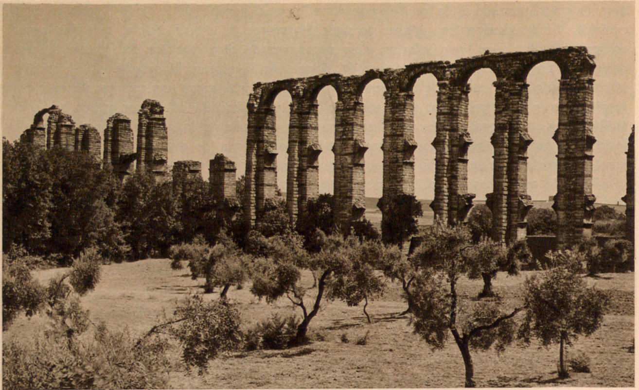
Fig. 11. — ACUEDUCTO DE LOS MILAGROS, EN MÉRIDA.
