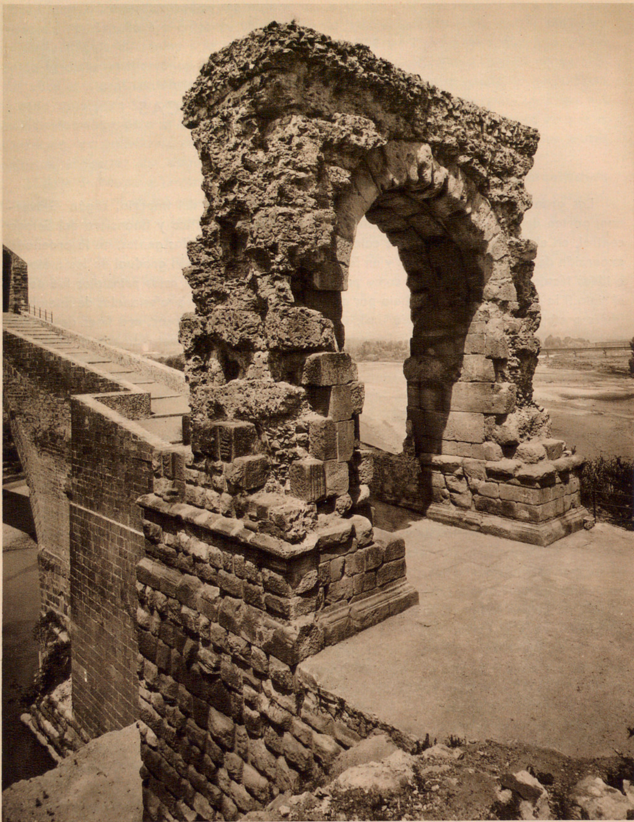
Fig. 1. — ARCO TRIUNFAL DE LA CABECERA DEL PUENTE DE MARTORELL (BARCELONA).
