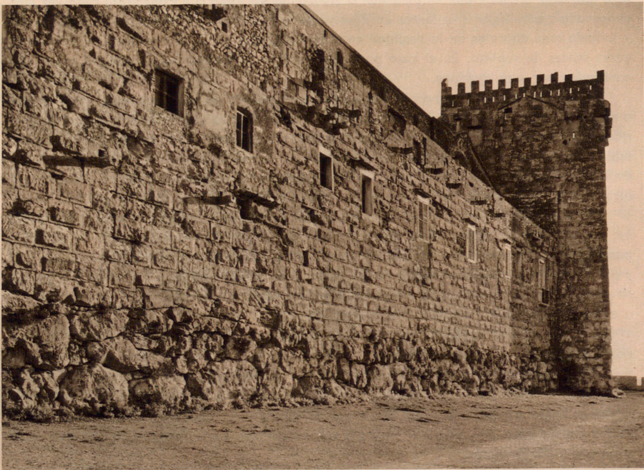
Fig. 14.— MURALLA ROMANA DE TARRAGONA CONSTRUÍDA SOBRE LOS MUROS CICLÓPEOS.
