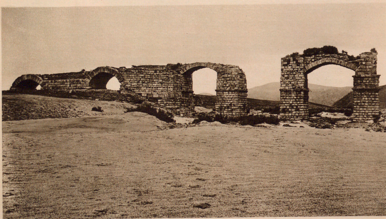
Fig. 3. — PUENTE DE ALCONÉTAR (CÁCERES).
