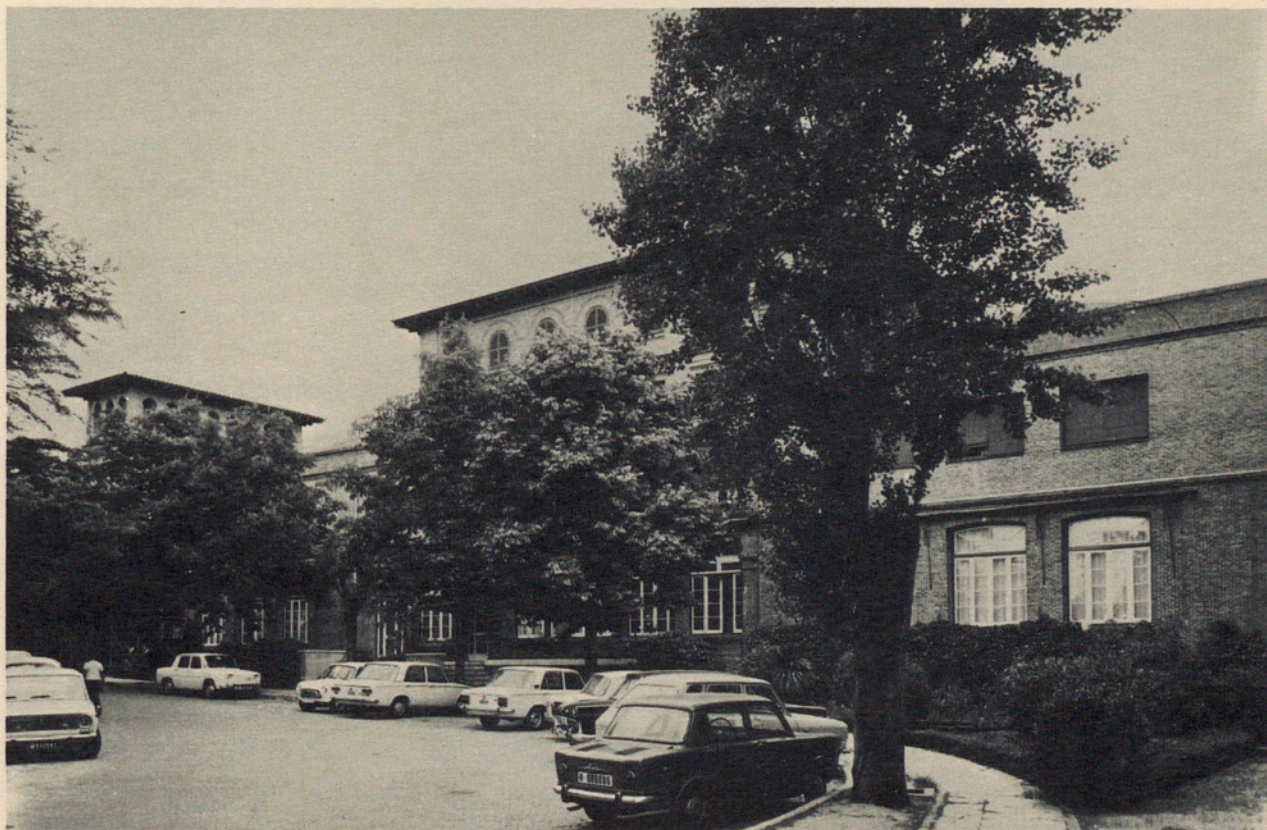
Figs. 51 y 52.—BARCELONA: PALACIO DE COMUNICACIONES Y CINE COLISEUM, POR F. DE P. NEBOT. Fig. 53.—MADRID: RESIDENCIA DE ESTUDIANTES, POR ANTONIO FLÓREZ.
