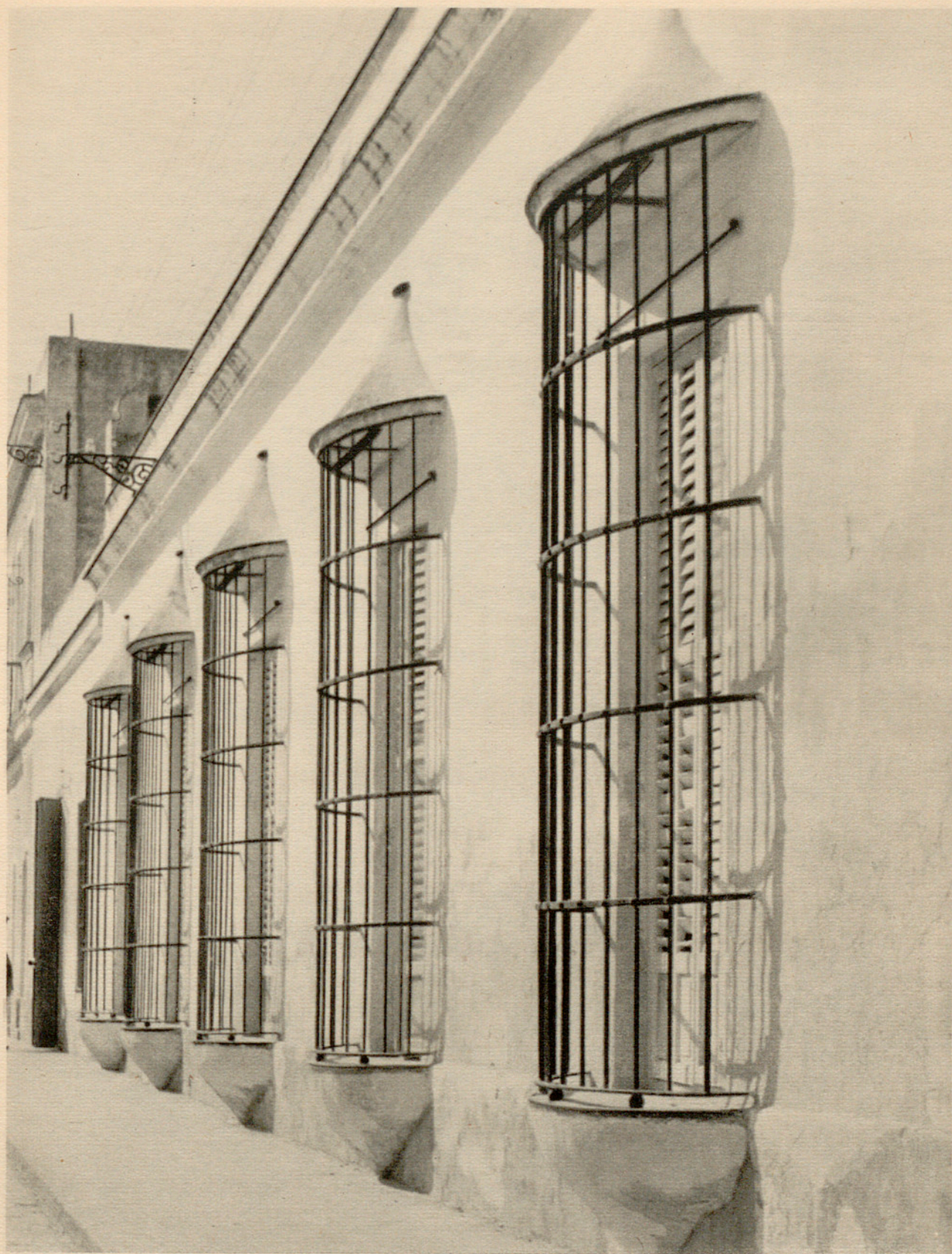
PUERTO REAL Rejas de planta semicircular en la Calle de San Antonio.
