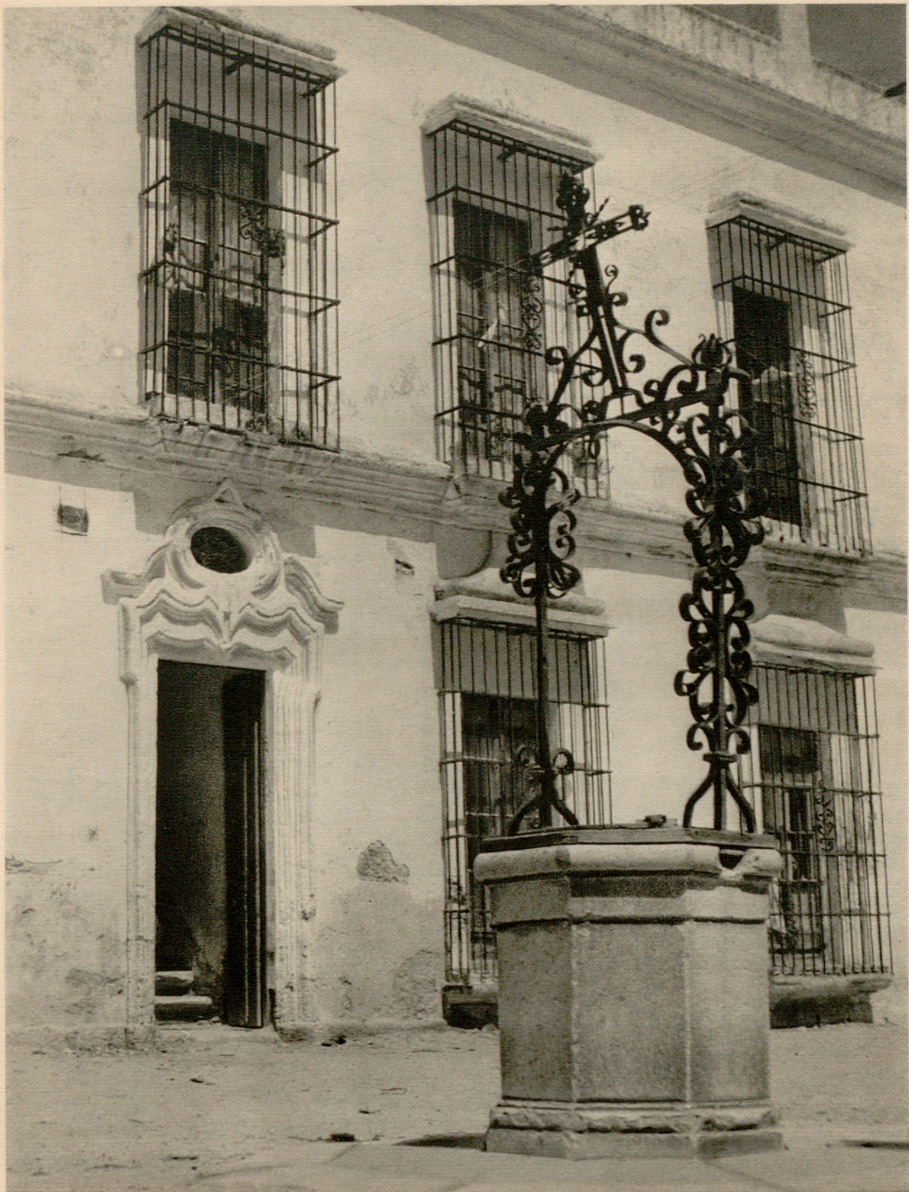
SAN FERNANDO Patio del Cambiazo. Pozo.
