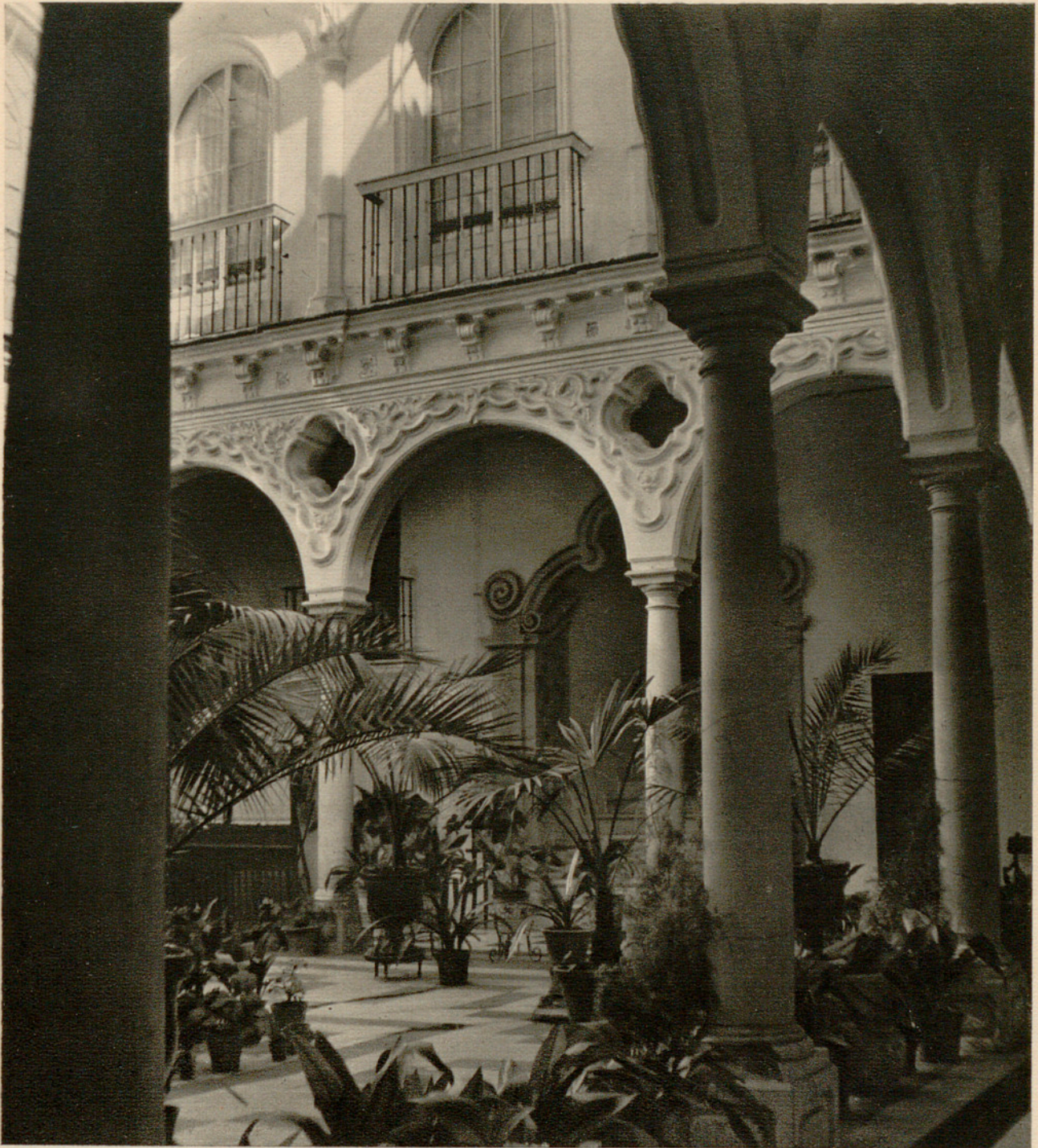
JEREZ DE LA FRONTERA Patio de la Casa del Marqués de Bertemati.
