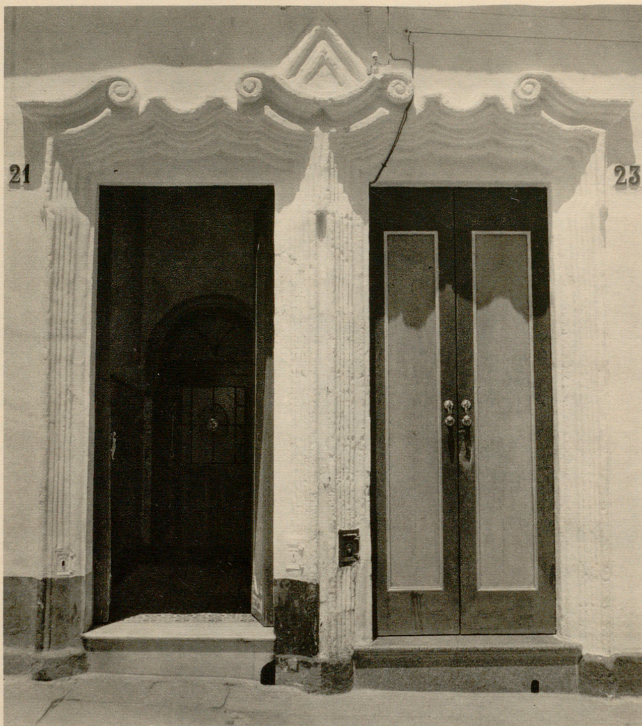
SAN FERNANDO Puertas gemelas en la calle General Espartero
