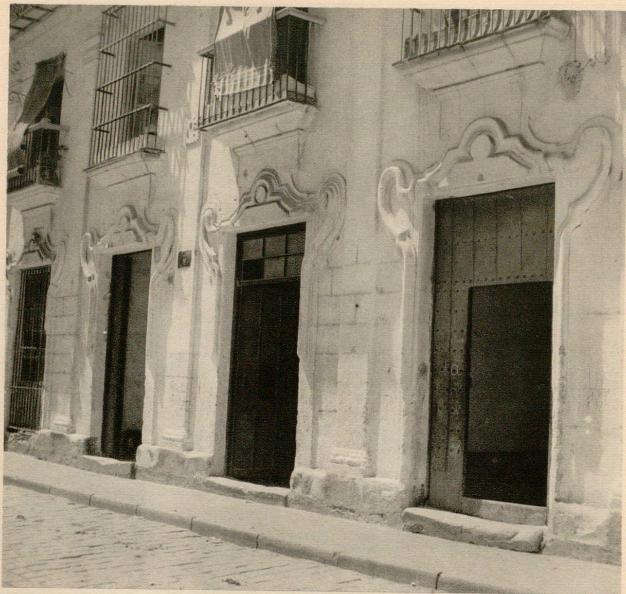
PUERTO DE SANTA MARIA Calle José Navarrete, antigua de Palacio. Casa del Marqués de Campo Real.
