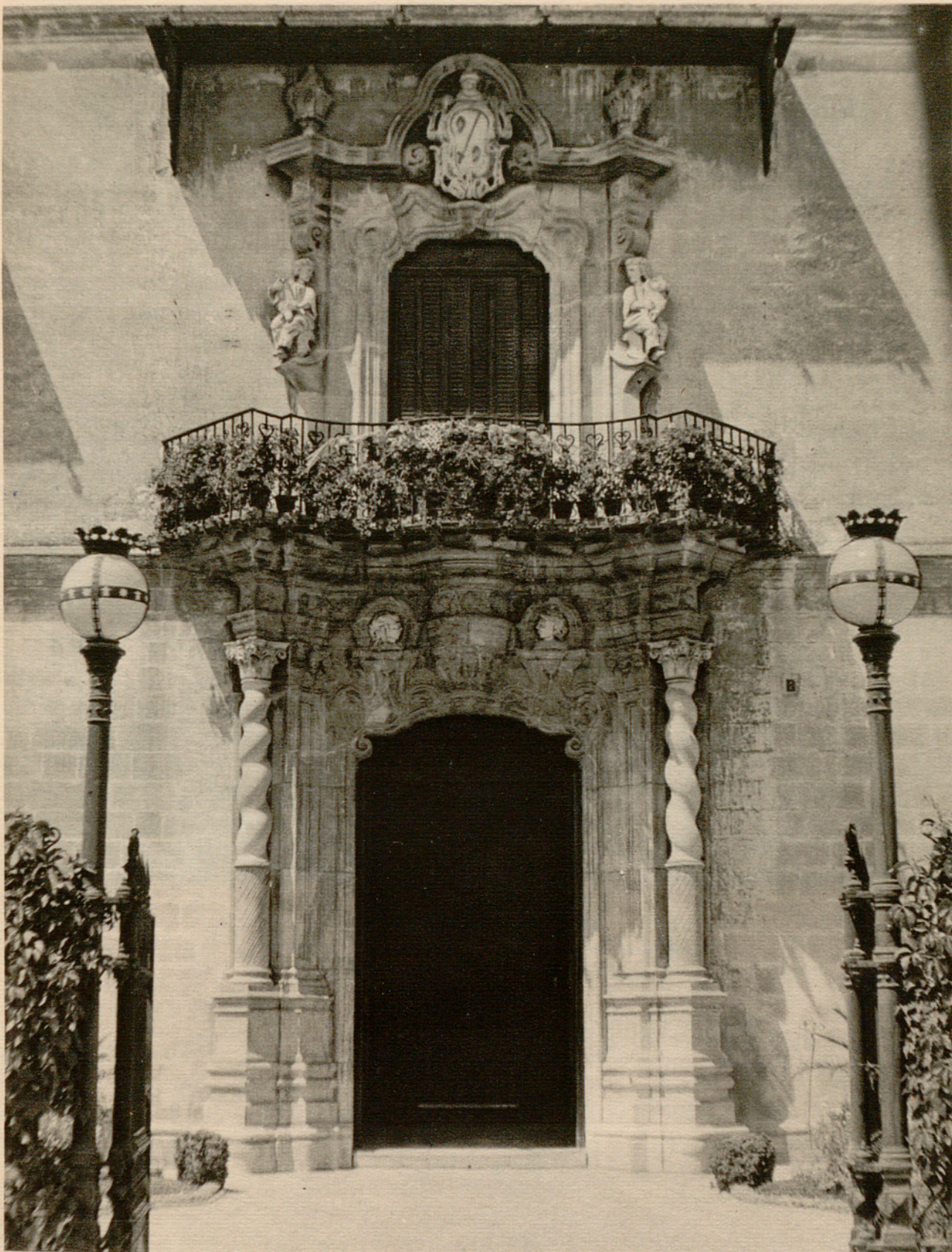
JEREZ DE LA FRONTERA Antigua Casa del Marqués de Montana (Actualmente del Marqués de Domecq.)
