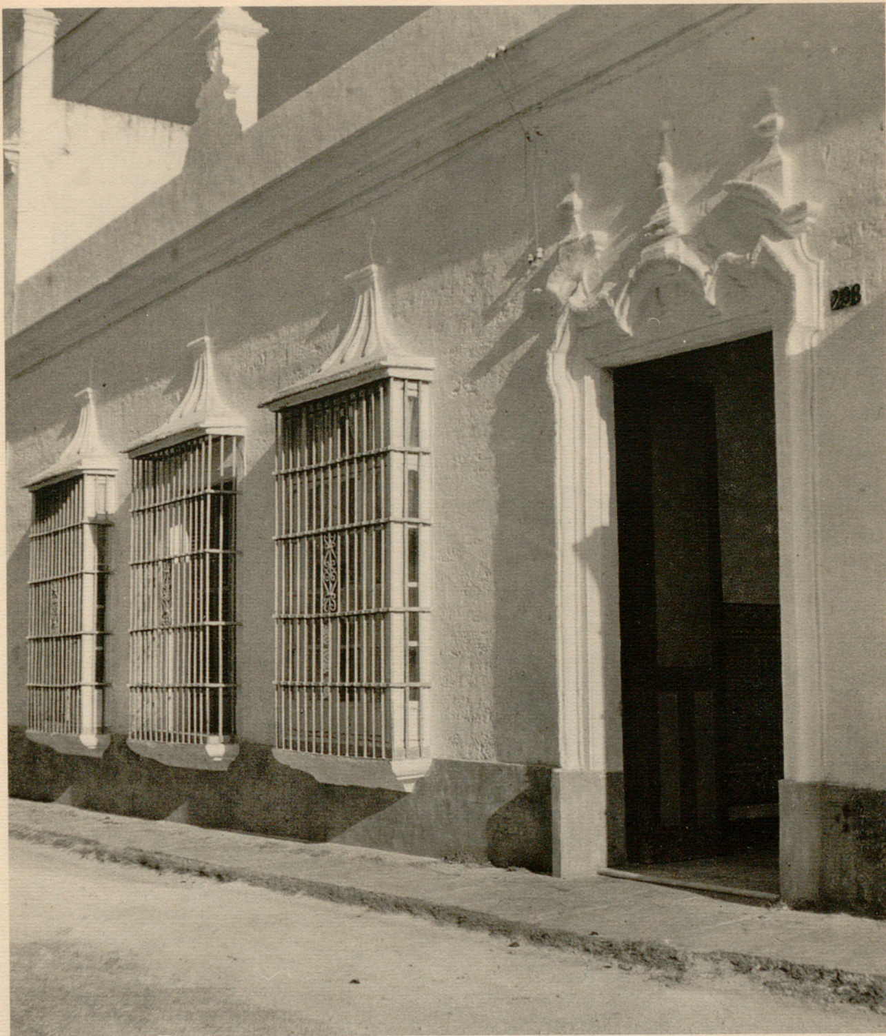
SAN FERNANDO Avda. General Varela. Portada y rejas.
