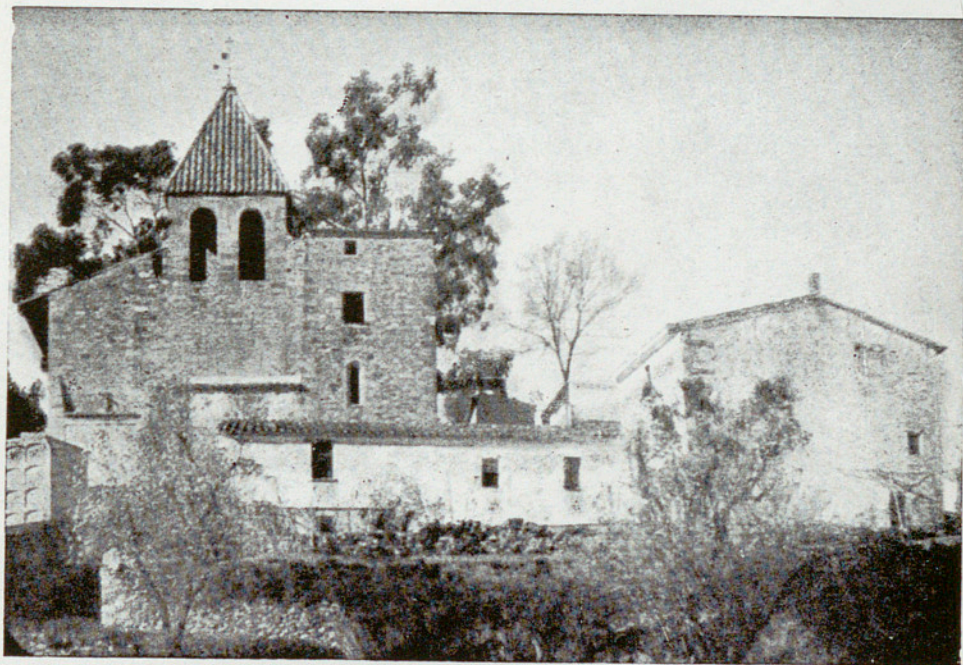
IV. - 1. Capella de la Mare de Déu del Camí, a can Terrés [12]. — 2. Conjunt d'edificis de La Doma; de Nord a Sud hom pot distingir: la casa del domer major; la casa allargada del domer menor; els dos pisos de la mongia, sobre la sagristia; el campanar, coronant la nau central de l'església, i la nau afegida al costat de l'epístola [17] ( clicés Ruaix ).
